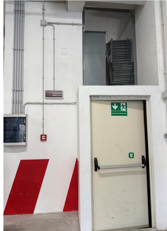
Vista dall'esterno del vano ascensore
