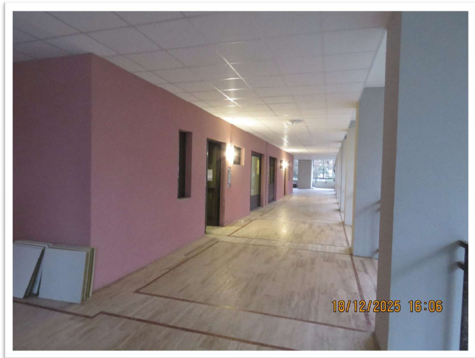
Percorsi esterni comuni ed ingresso alla scala "B".
