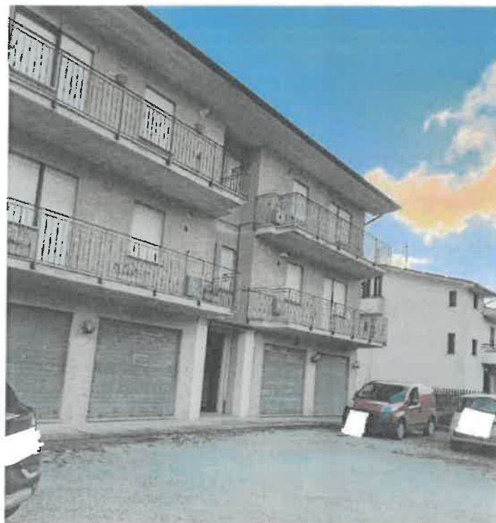
FOTO 2 – Seconda vista dall'esterno del fabbricato.
