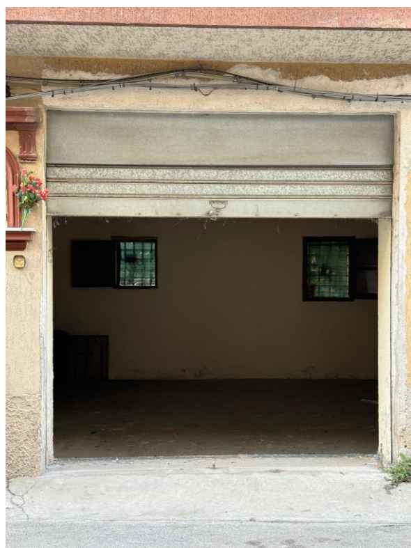
Foto 3 - Ingresso al garage con salacinesca metallica.
