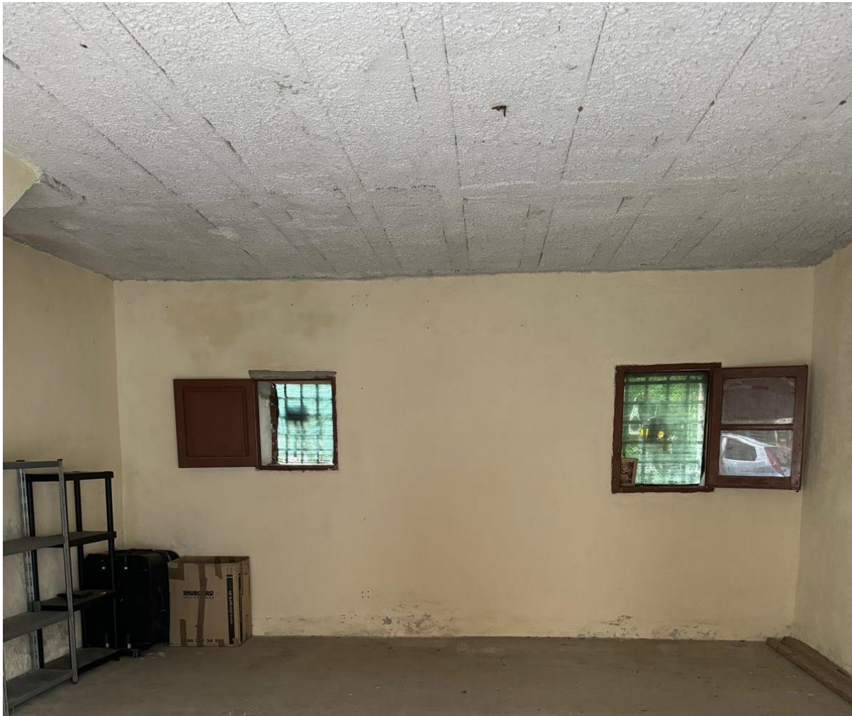
Foto 5 – Interno del garage
