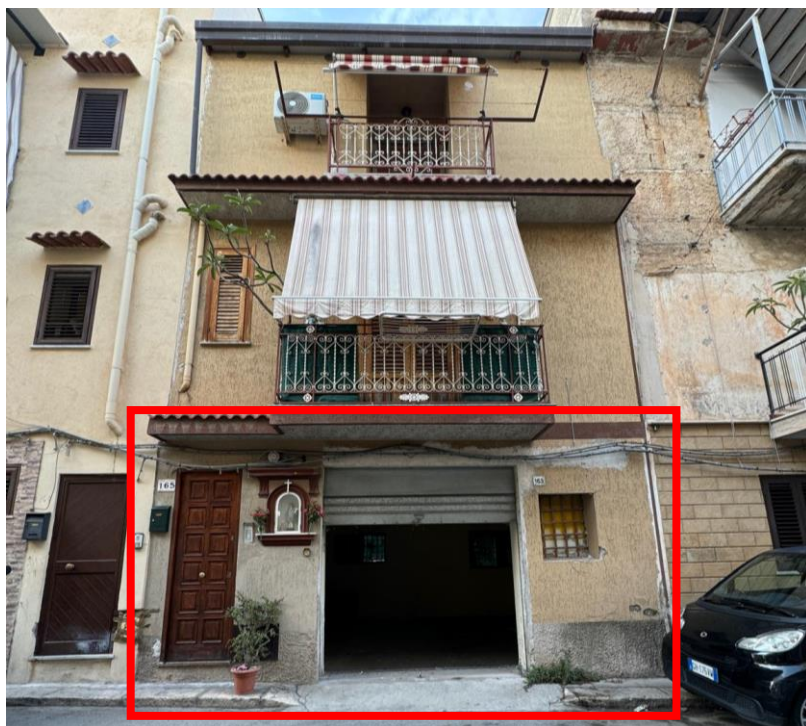
Foto 1 – Il prospetto sulla Via Altarello. Nel riquadro in rosso l'immobile oggetto del procedimento.
