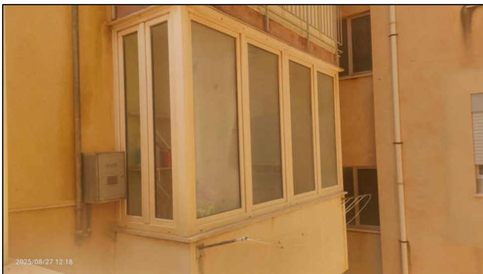
Foto n°17 : balcone coperto visto dall'esterno
