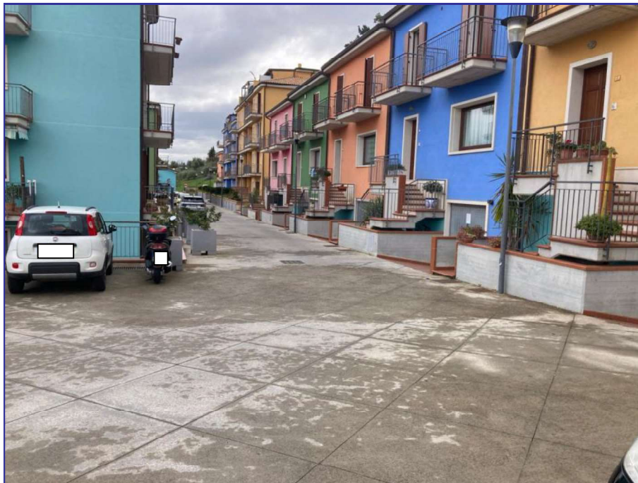
Foto 20 – Imm. 2 - Area destinata a parcheggio e viabilità a servizio degli edifici costruiti sui lotti C, D e E (Part. 1222).
