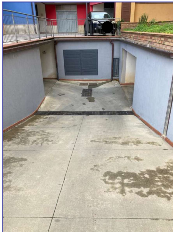
Foto 22 – Imm. 3 - Rampa a servizio del lotto E e D per raggiungere il vano contatori energia elettrica (Part. 1176).
