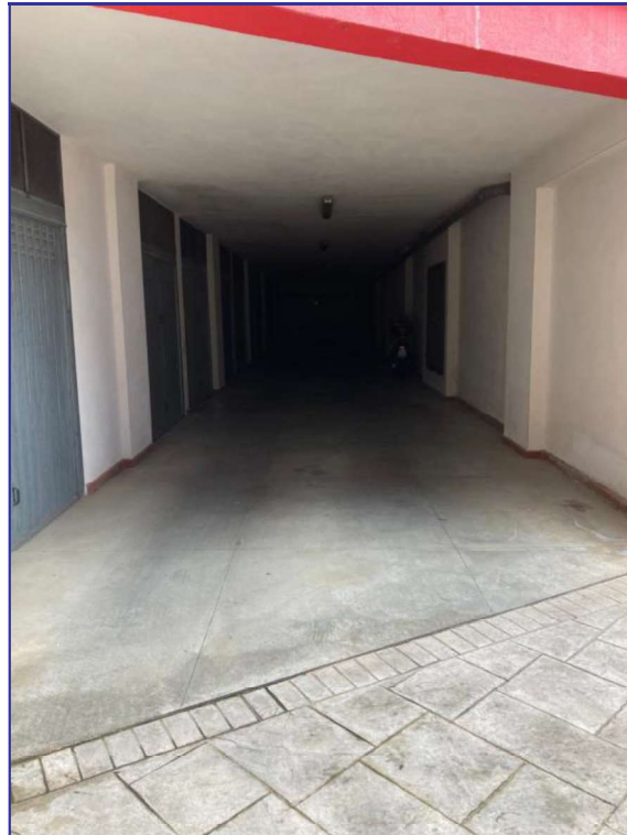
Foto 9 – Imm.1 - Corsia di manovra ai box auto piano terra (bene comune non censibile part. 1163 sub. 2).
