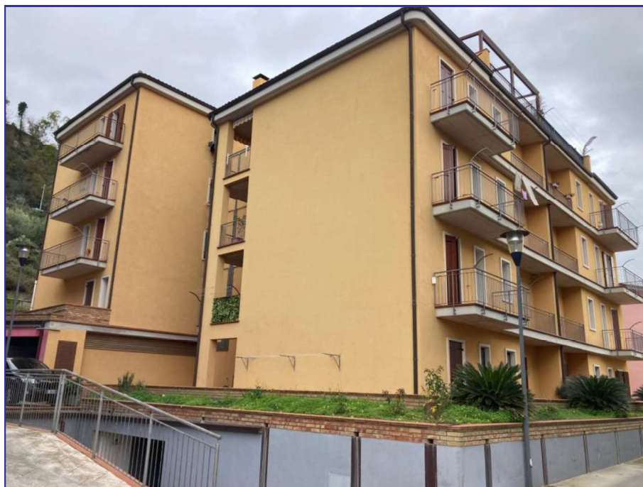
Foto 4 – Imm.1 - Altra vista del prospetto dell'Edificio N. 17.
