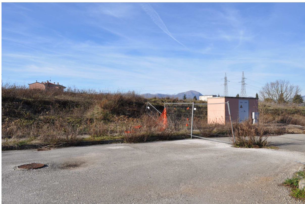
Foto 20 - cabina elettrica su mappale 1082
