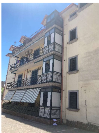
Foto esterno fabb.to lato nord
