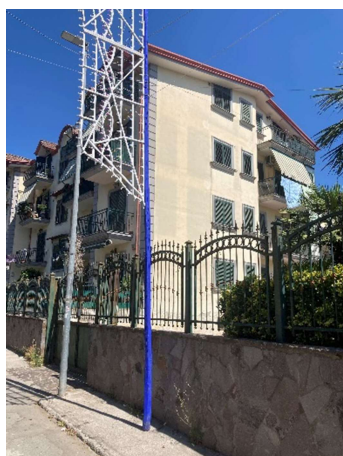
Foto esterno fabb.to lato sud_est
