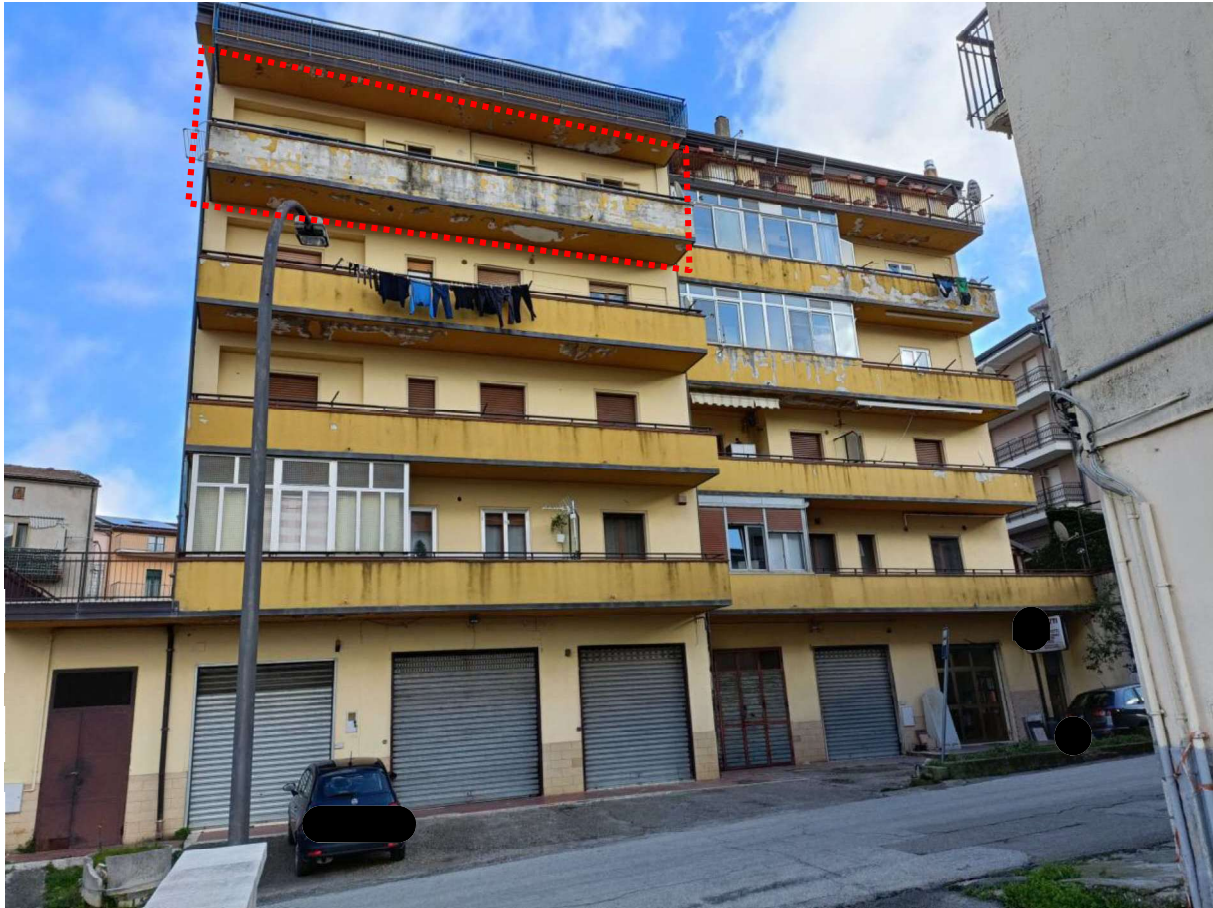
Figura 1 – Panoramica Fabbricato, Foglio 22, Particella 267, Sub 20, Cancellara (PZ).
