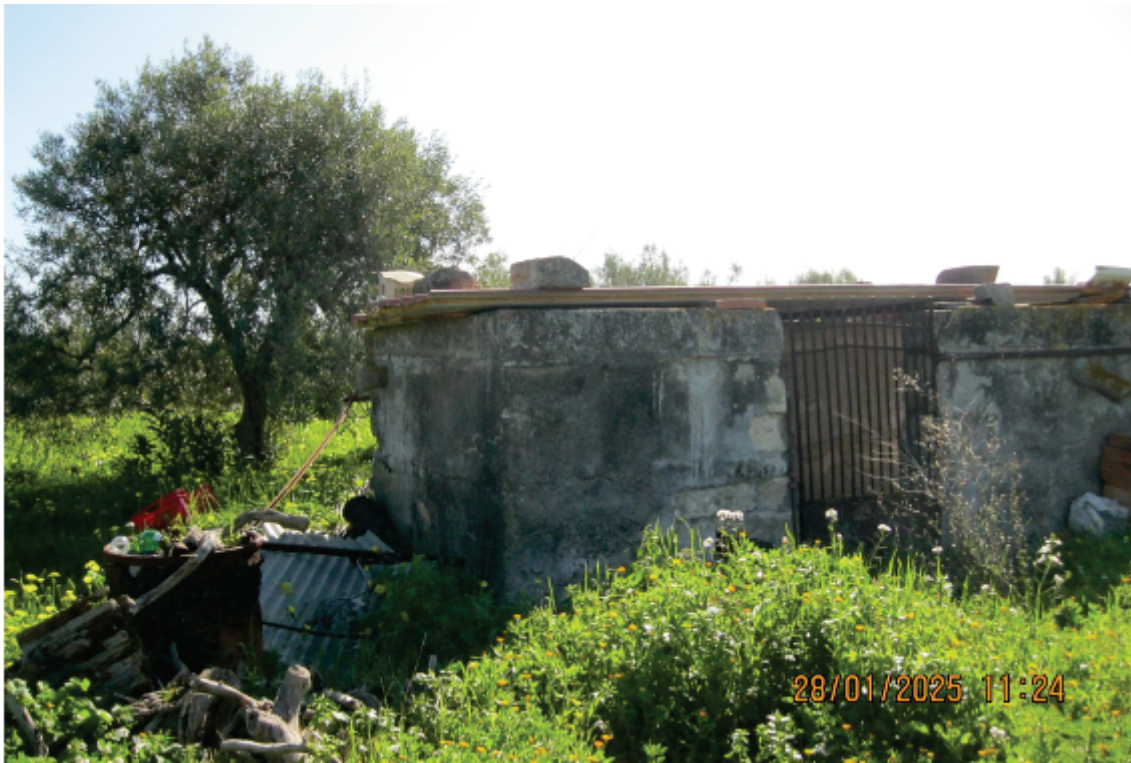
Foto 13: il fabbricato adibito a porcaia visto dall'esterno
