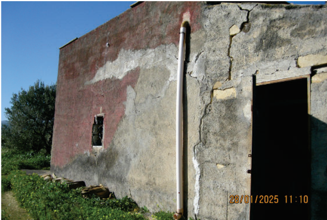
Foto 1: due dei tre magazzini adiacenti tra loro, visti dall'esterno
