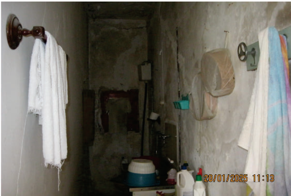
Foto 10: il corridoietto presente all'interno del magazzino con installato un wc ed un lavandino
