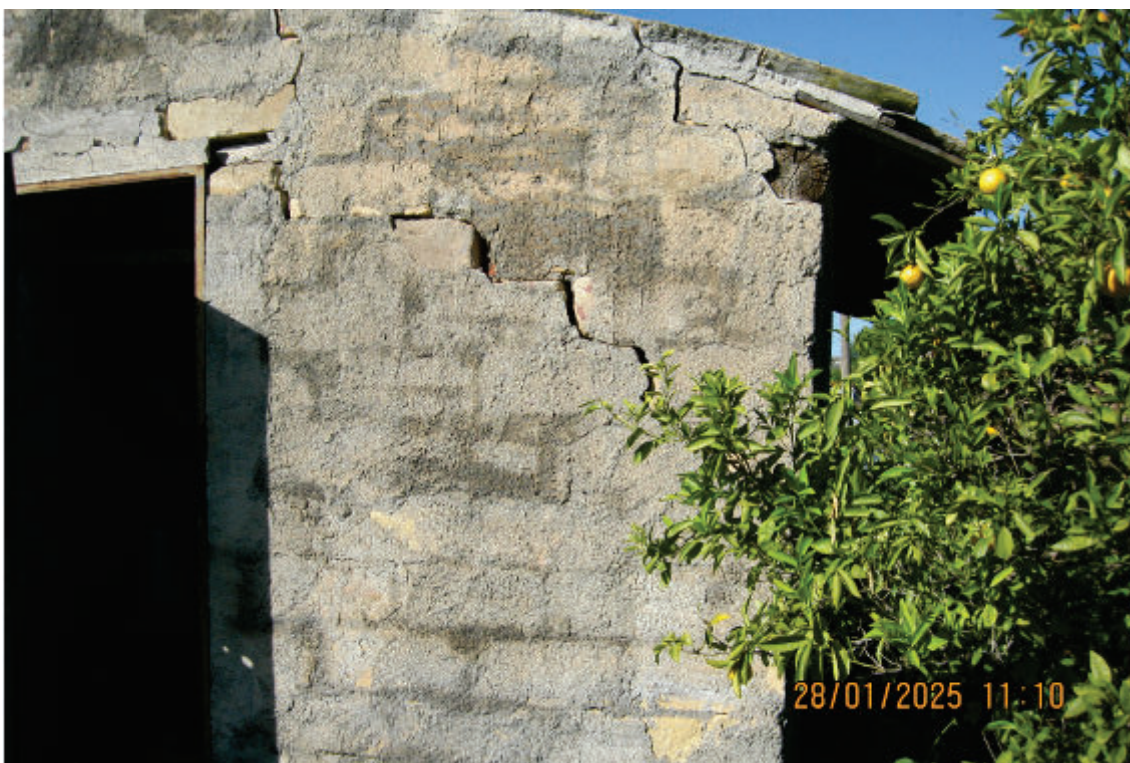
Foto 2: uno dei tre magazzini visto dall'esterno
