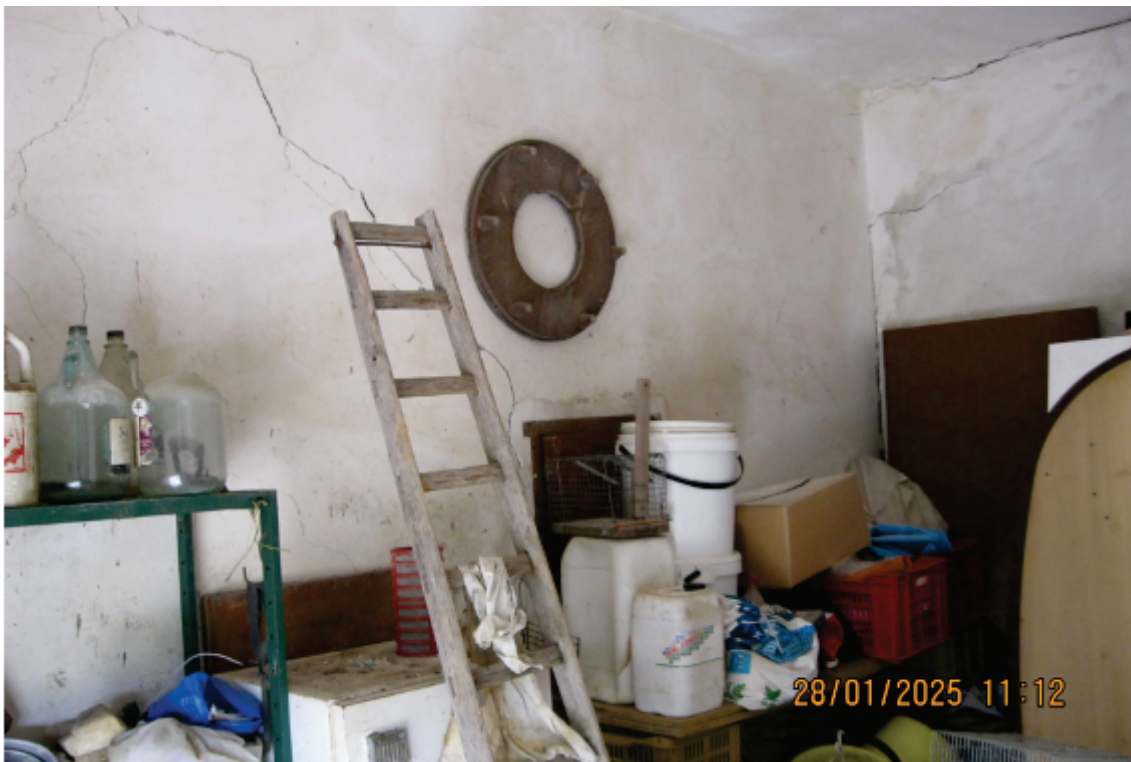
Foto 6: il magazzino della foto precedente visto dall'interno
