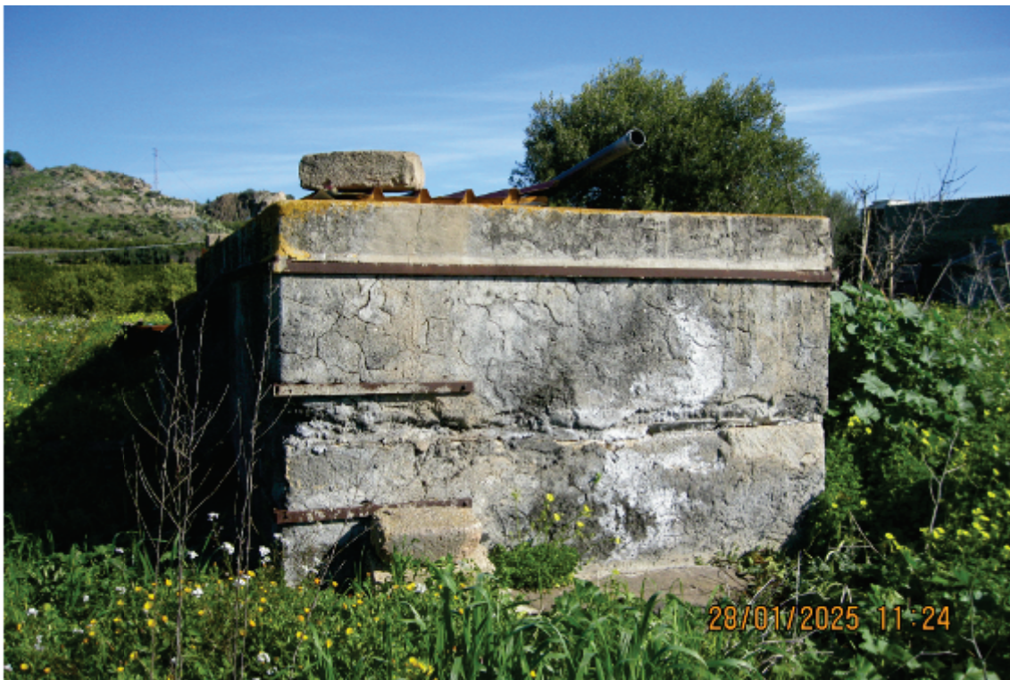
Foto 12: altro prospetto del fabbricato adibito a porcilaia
