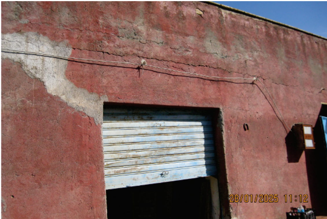
Foto 5: il secondo magazzino visto dall'esterno
