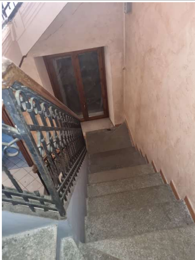
VANO SCALA CON FINESTRA SU VANO CHIUSO
