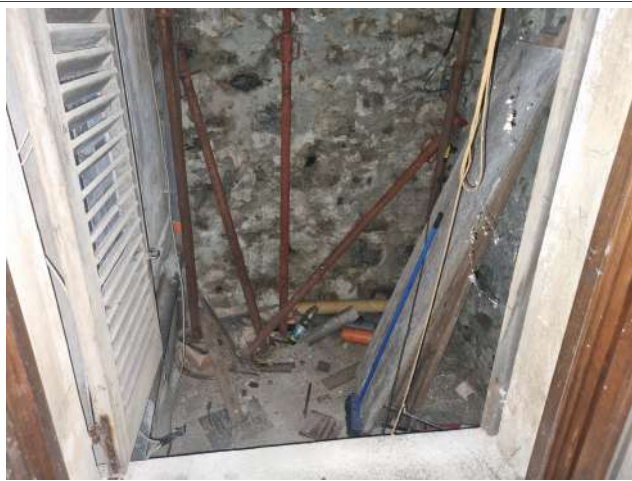
VANO A FIANCO DEL BAGNO VISTA DA FINESTRA
