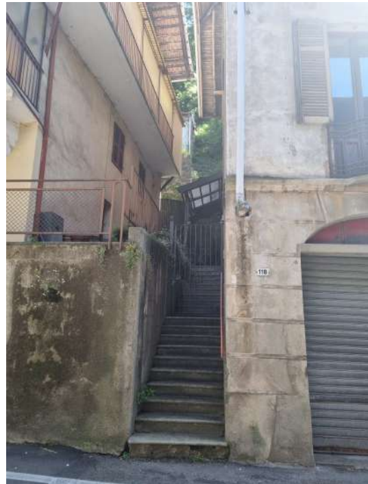
SCALA DI ACCESSO ESTERNA VIA ROMA
