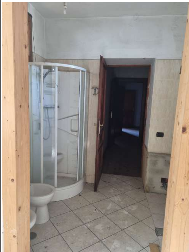
BAGNO VERSO CAMERA 3
