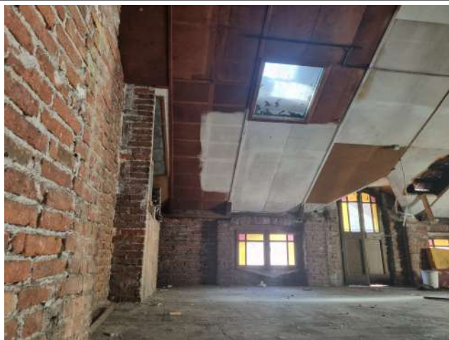
SOTTOTETTO VERSO VIA ROMA
