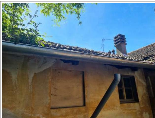
TETTO SU BAGNO
