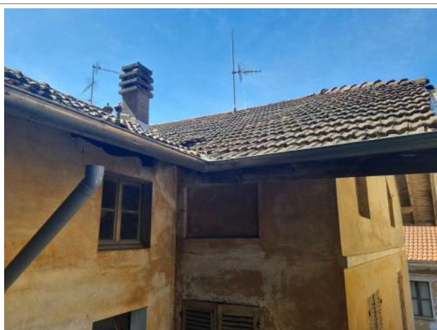
TETTO ZONA BAGNO E CAMERA
