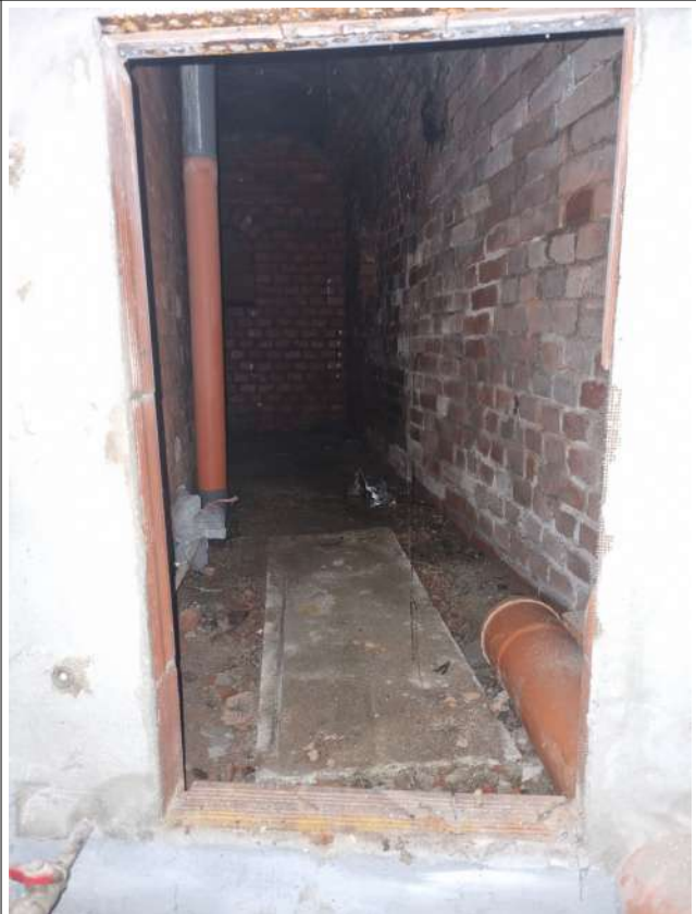
VANO CON SCARICHI A FIANCO DELLA SCALA
