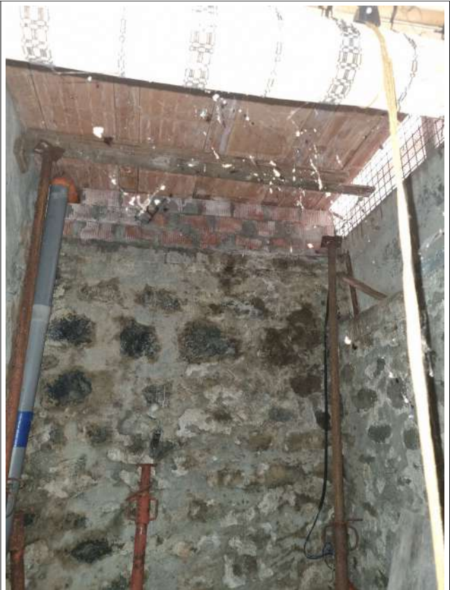
VANO A FIANCO DEL BAGNO VISTA DA FINESTRA
