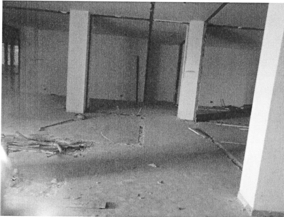
INTERNO DELL'APPARTAMENTO FOGLIO 101 PART. 169 SUB. 13 IN FASE DI RISTRUTTURAZIONE
