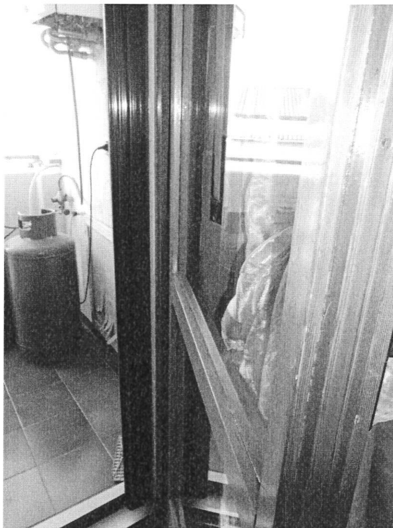
INFISSI DELL'APPARTAMENTO FOGLIO 101 PART. 169 SUB.13
