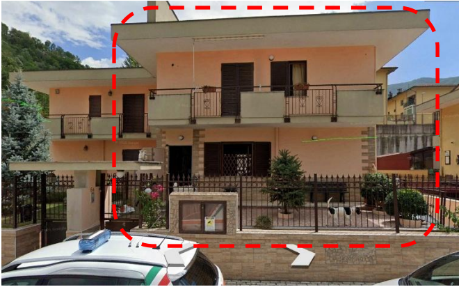
Foto : prospetto principale fronte strada [ nord-ovest]
