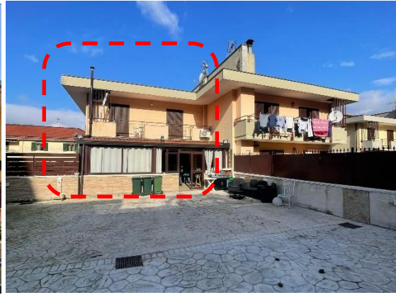
Foto: prospetto posteriore lato giardino [ sud est]
