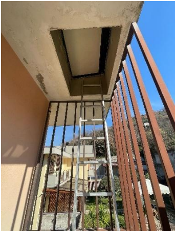
Foto 7: scala d'accesso al tetto
