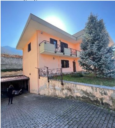
Foto 13: esterna- rampa d'accesso
