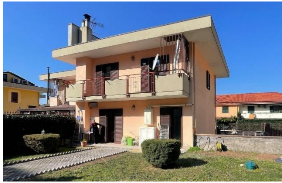
Foto: prospetto posteriore lato giardino [ sud est]
