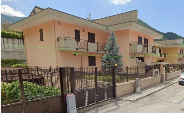
Foto : prospetto principale fronte strada [ nord-ovest]
