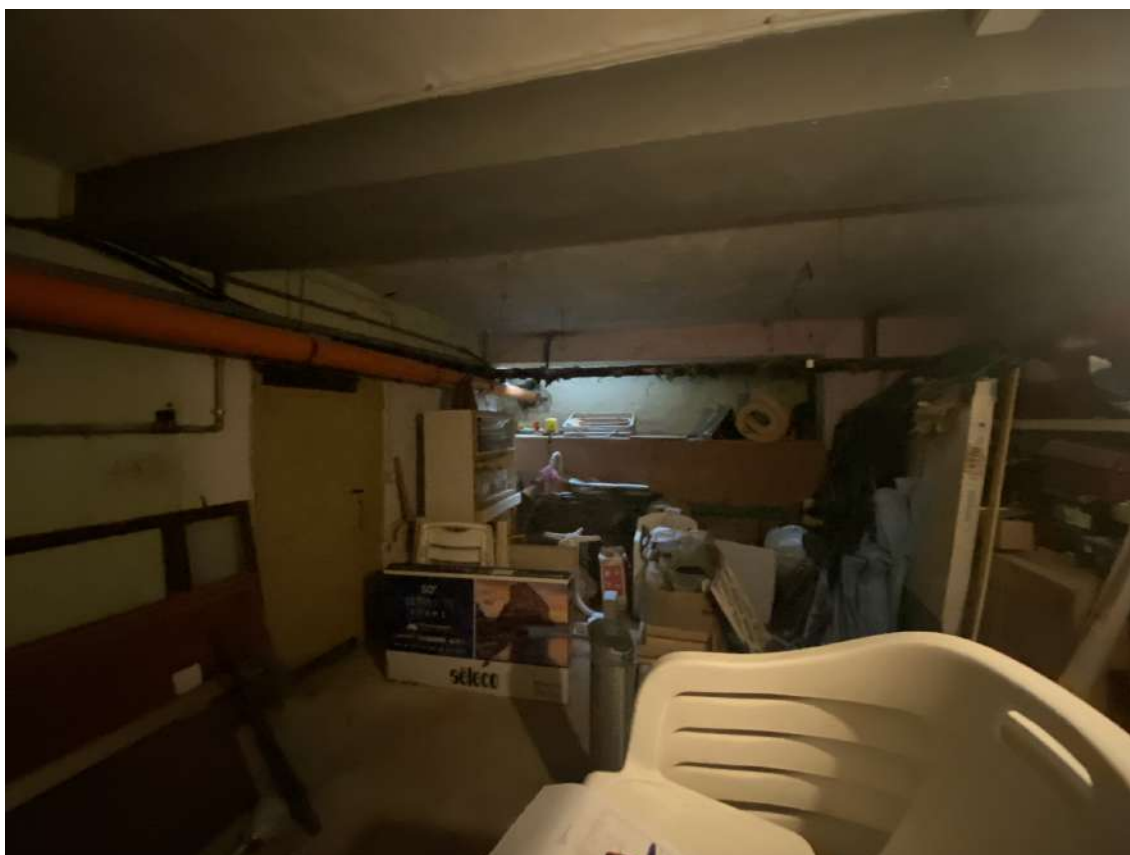
Foto 20: Vista del primo vano cantina/deposito al PS1.
