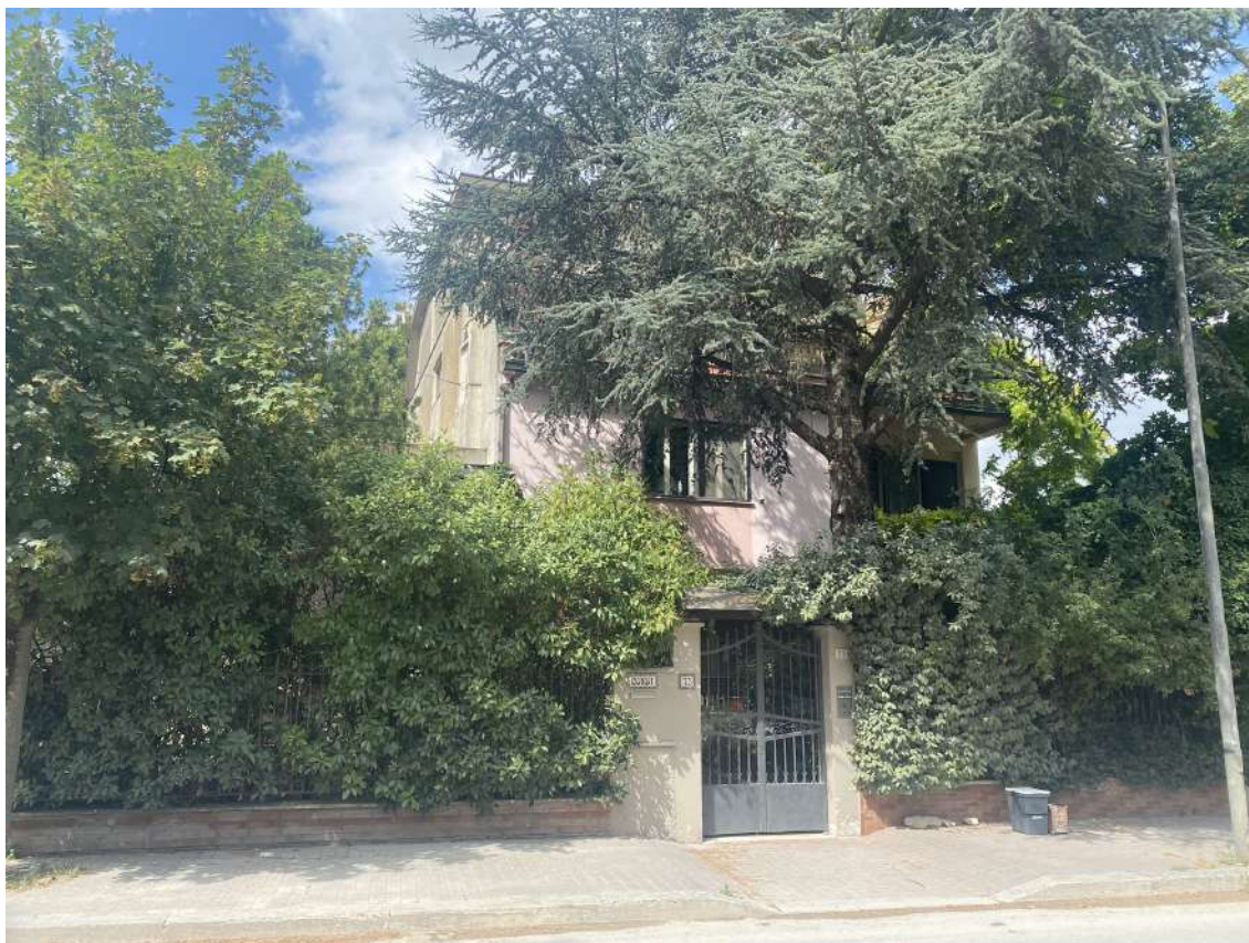
Foto 3: Vista d'insieme del fabbricato di appartenenza dell'abitazione su Via Monte Velino.
