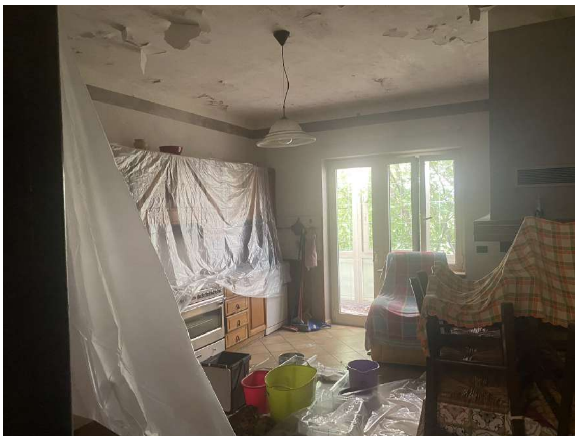
Foto 10: Vista della cucina.
