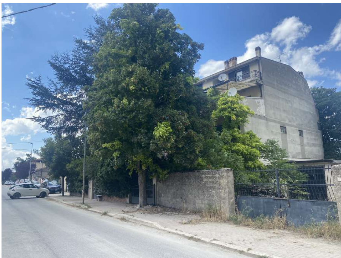
Foto 4: Vista d'insieme del fabbricato di appartenenza dell'abitazione su Via Monte Velino.
