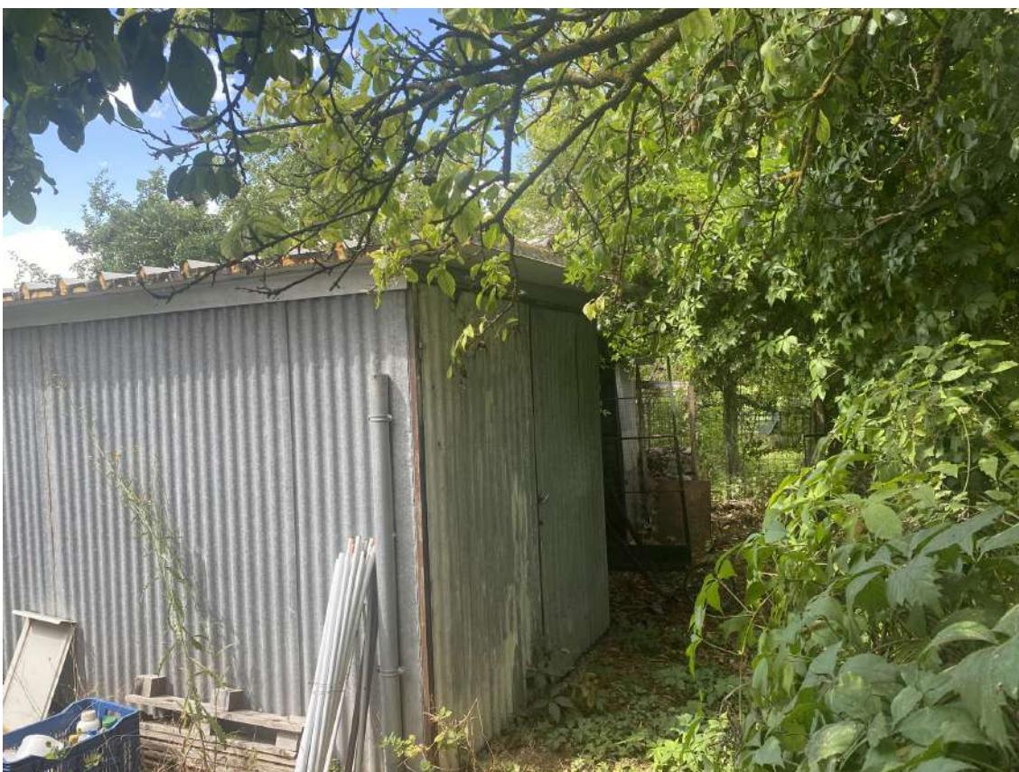
Foto 24: Vista della corte esclusiva retrostante i garages ed il manufatto da rimuovere.
