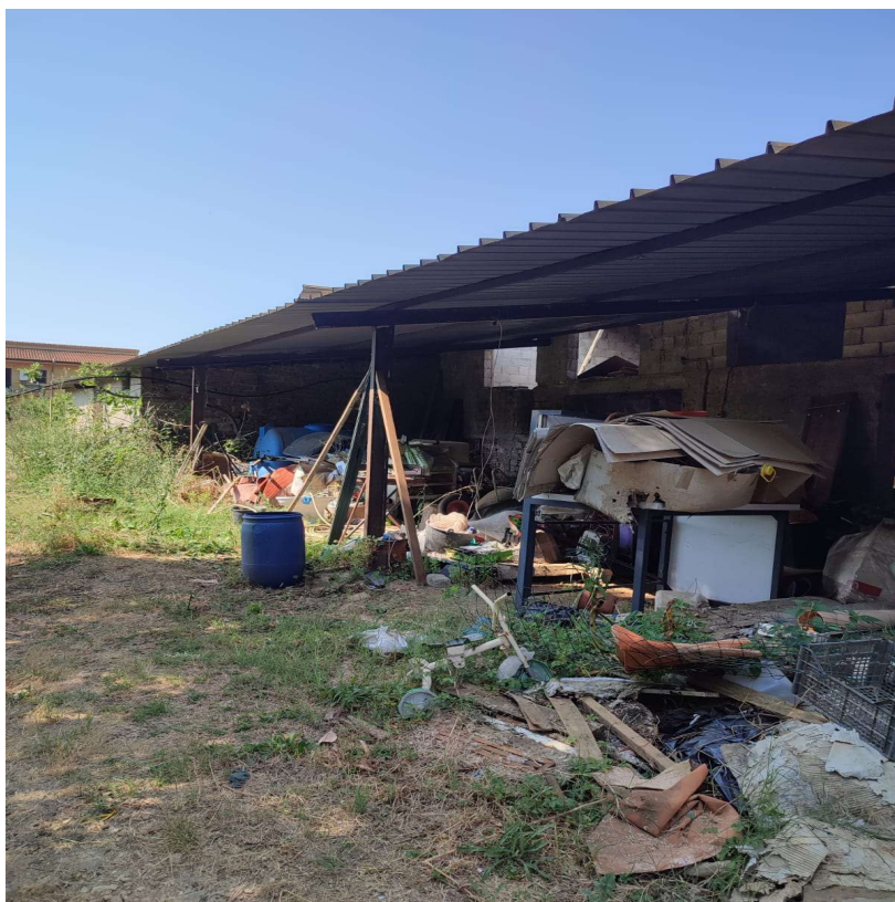
Foto 9 – Locali di sgombero
