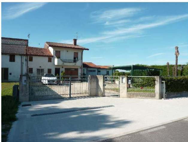
Vista del compendio da Via Caseggiato
