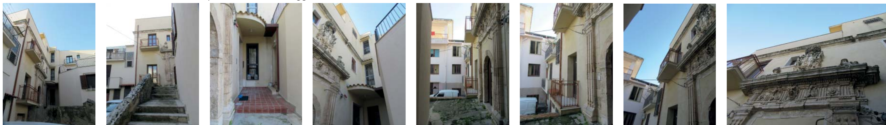
Foto da 9 a 16, prospetto prospiciente sulla corte di accesso del fabbricato comprendente il lotto in oggetto
