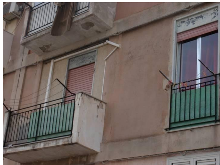
1.2. 3. Fabbricato in cui è sito l'immobile, prospetto su via G. Reale
