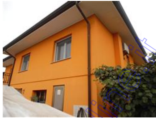
Prospetti ovest e sud da scoperto di proprietà - abitazione
