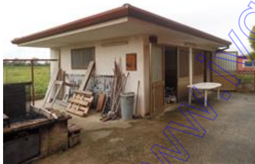
Prospetti sud ed est da scoperto di proprietà - fabbricato accessorio, deposito
