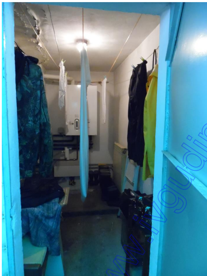
Fabbricato accessorio, centrale termica – p.T
