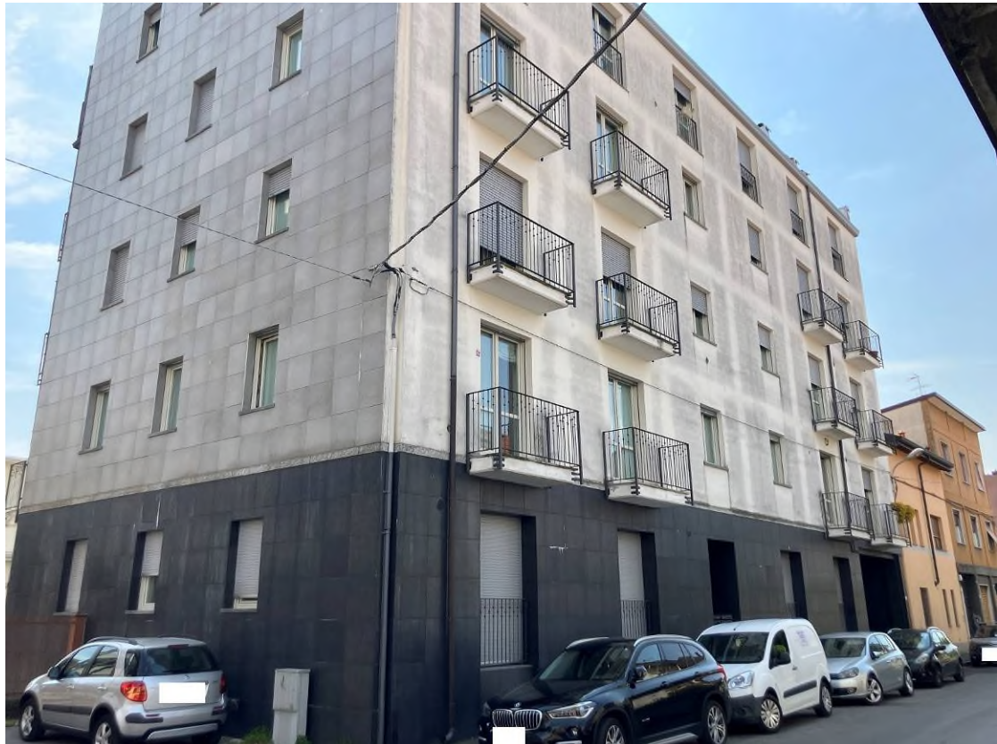
Vista fronte nord-est
