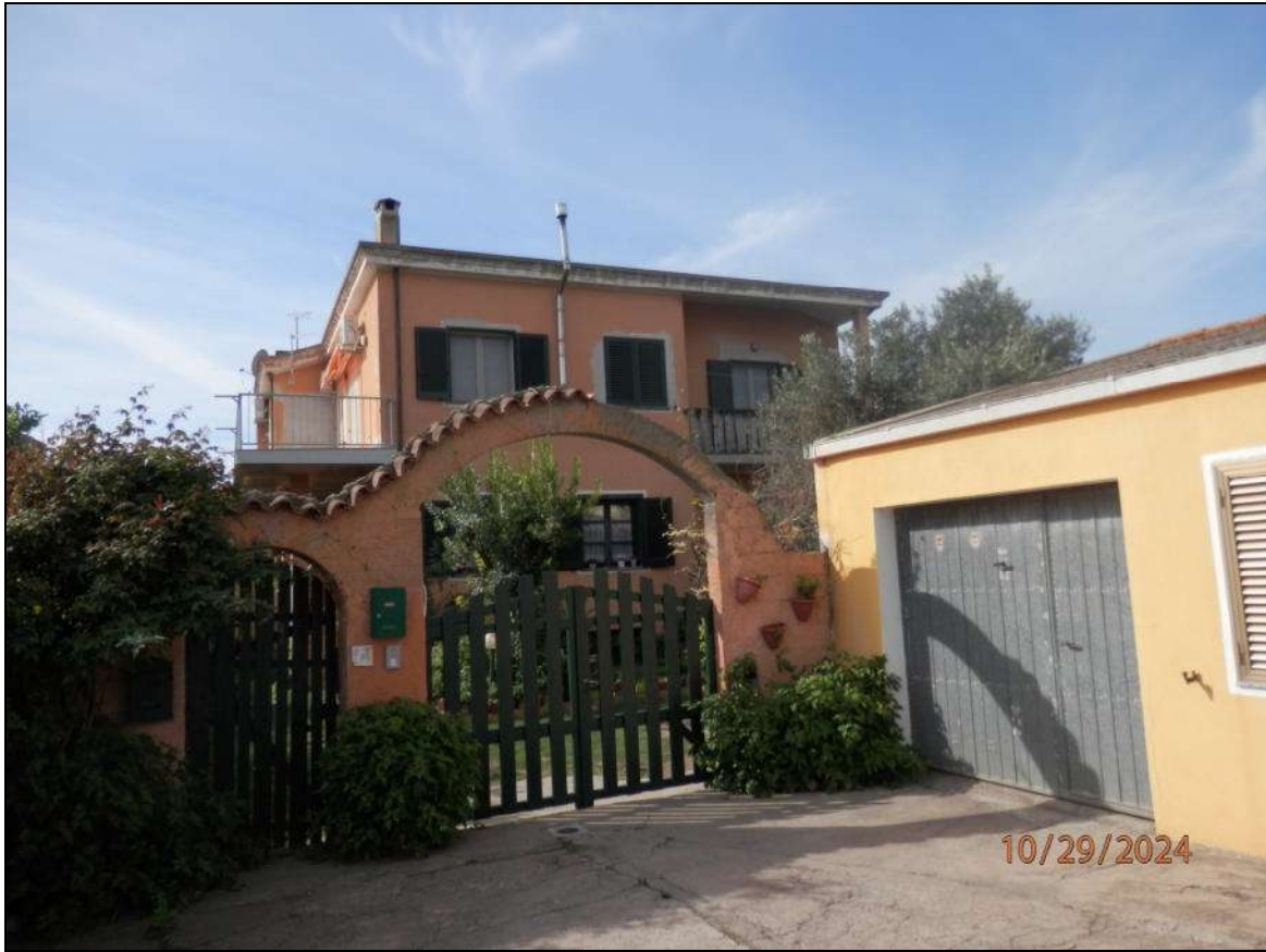
Fotografia N. 1 - Vista dalla Via Monte Grappa
