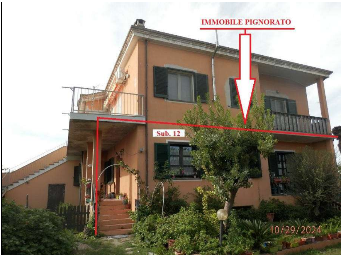
Fotografia N. 2 - Vista prospetto Nord-Est dal cortile interno
