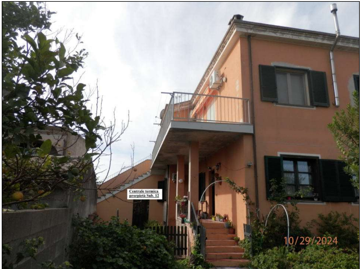
Fotografia N. 3 - Vista prospetto Est dal cortile interno
