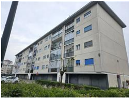
Facciata nord del Condominio
