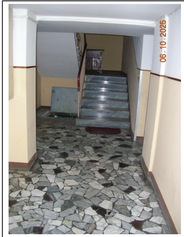
Ingresso e scala comune di accesso alle unità
