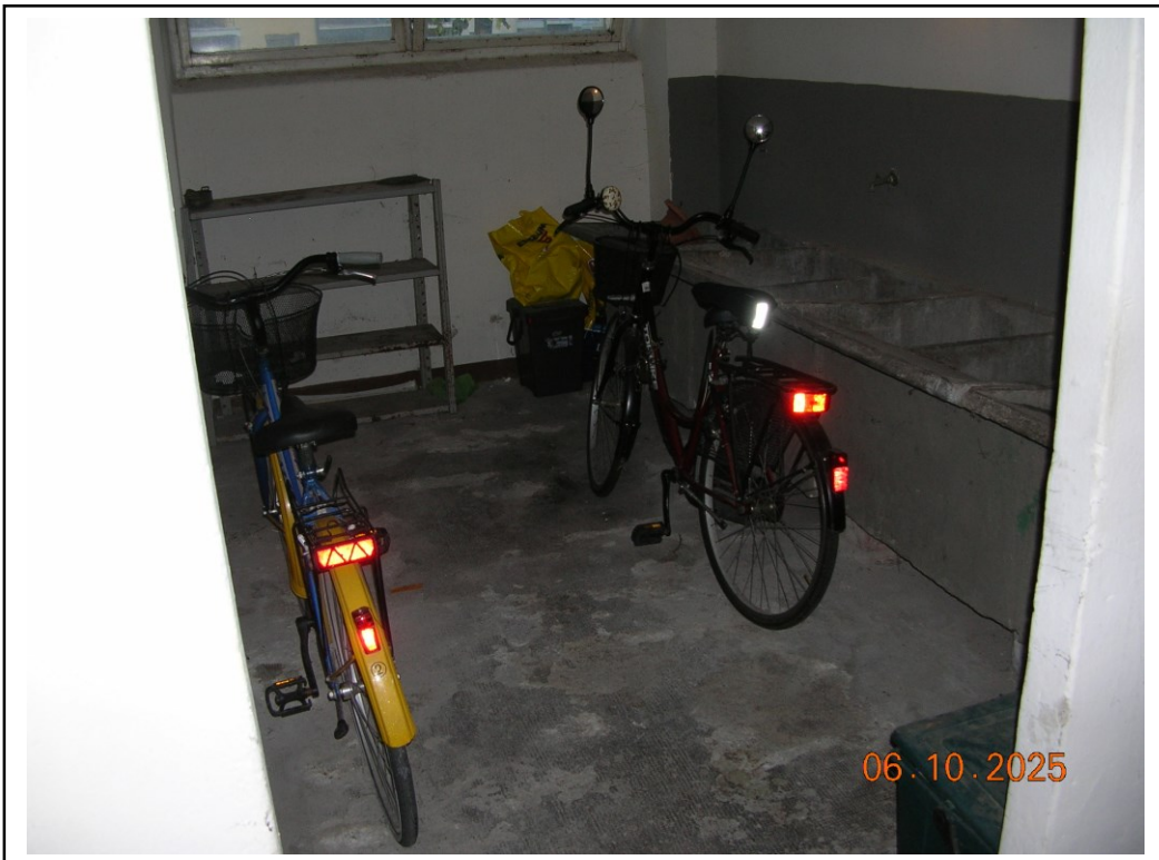
Lavatoio comune posto al Piano Terra
