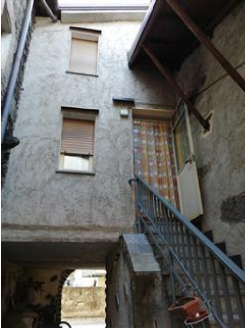
fronte nord mapp. 136 accesso da scala esterna
