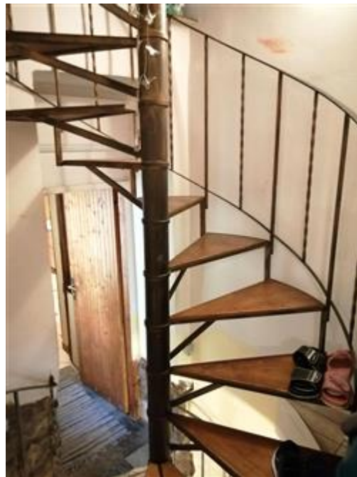
scala interna di collegamento
