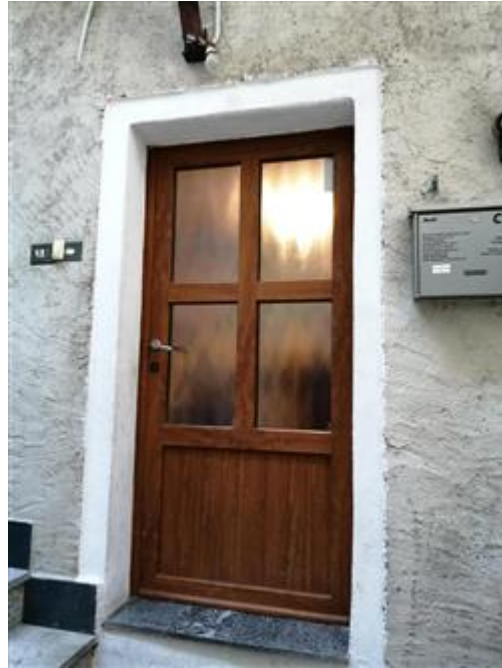
fronte est mapp. 115 accesso piano terra
