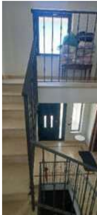
3- Vano Scale comune BCNC sub.1
