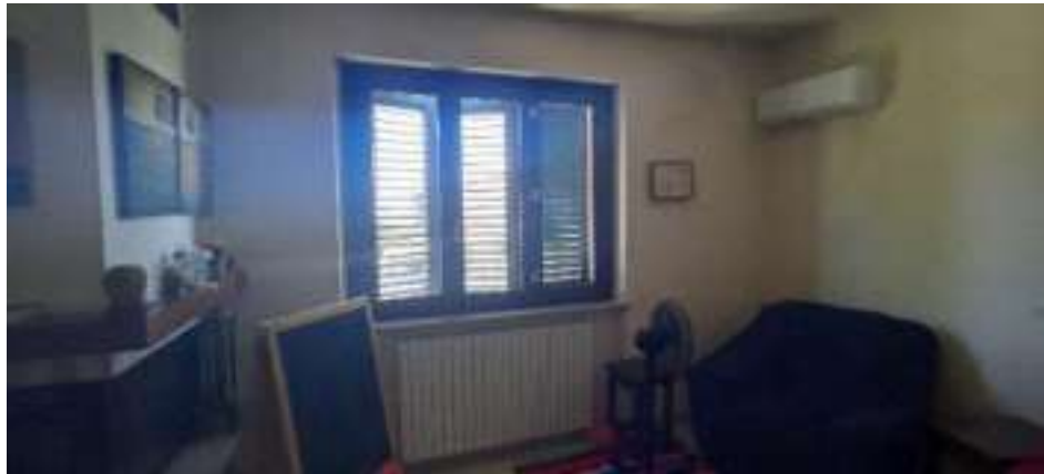
5- Salotto con Finestra non conforme allo stato autorizzato
