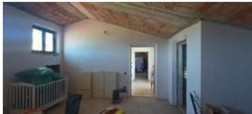
15. Soffitta allo stato grezzo
