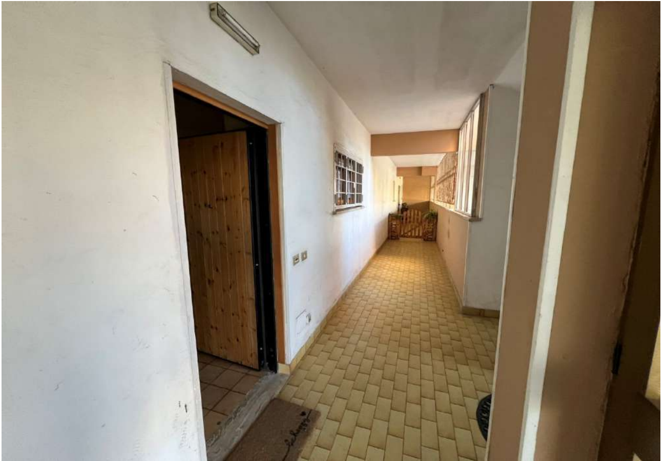
FOTO 5: Veduta ballatoio condominiale di accesso piano terra
