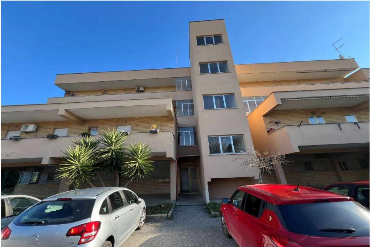
FOTO 1: Veduta esterna prospettivo principale
