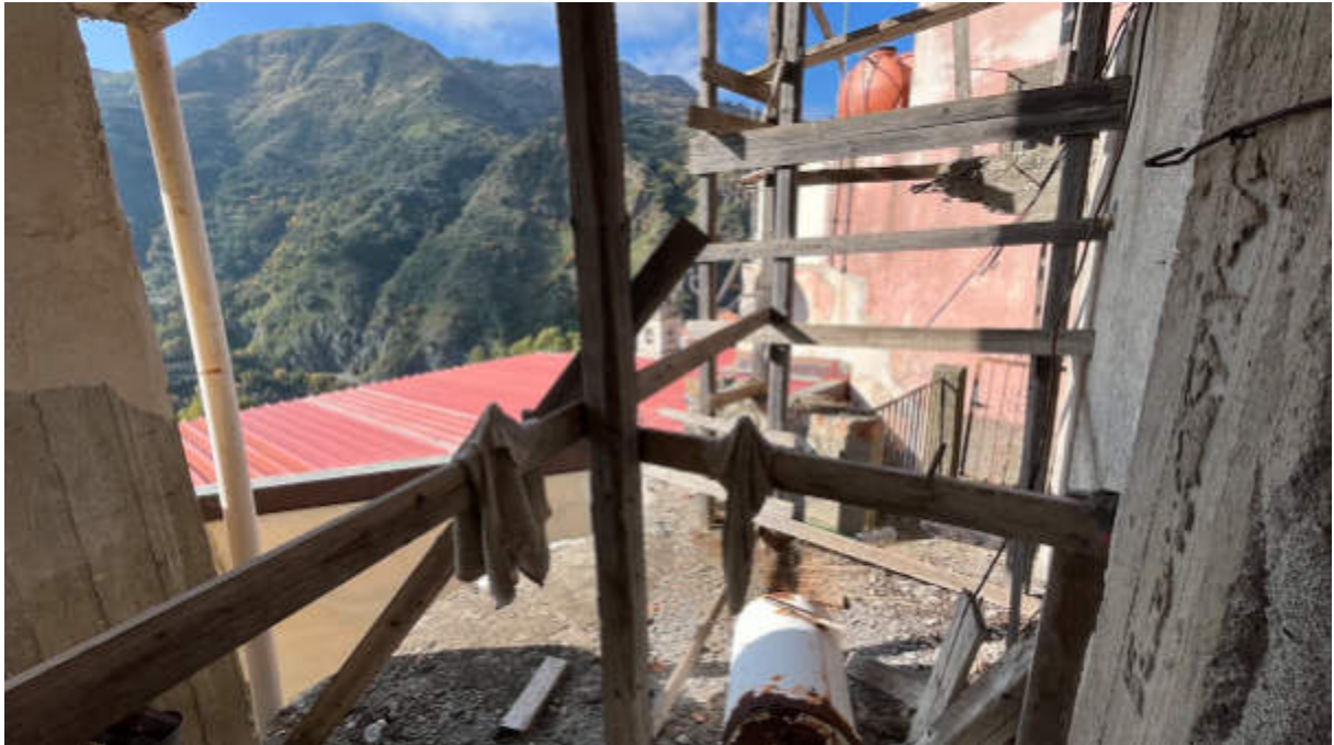
7. Vista 1 su Terrazzo al Piano Terra
