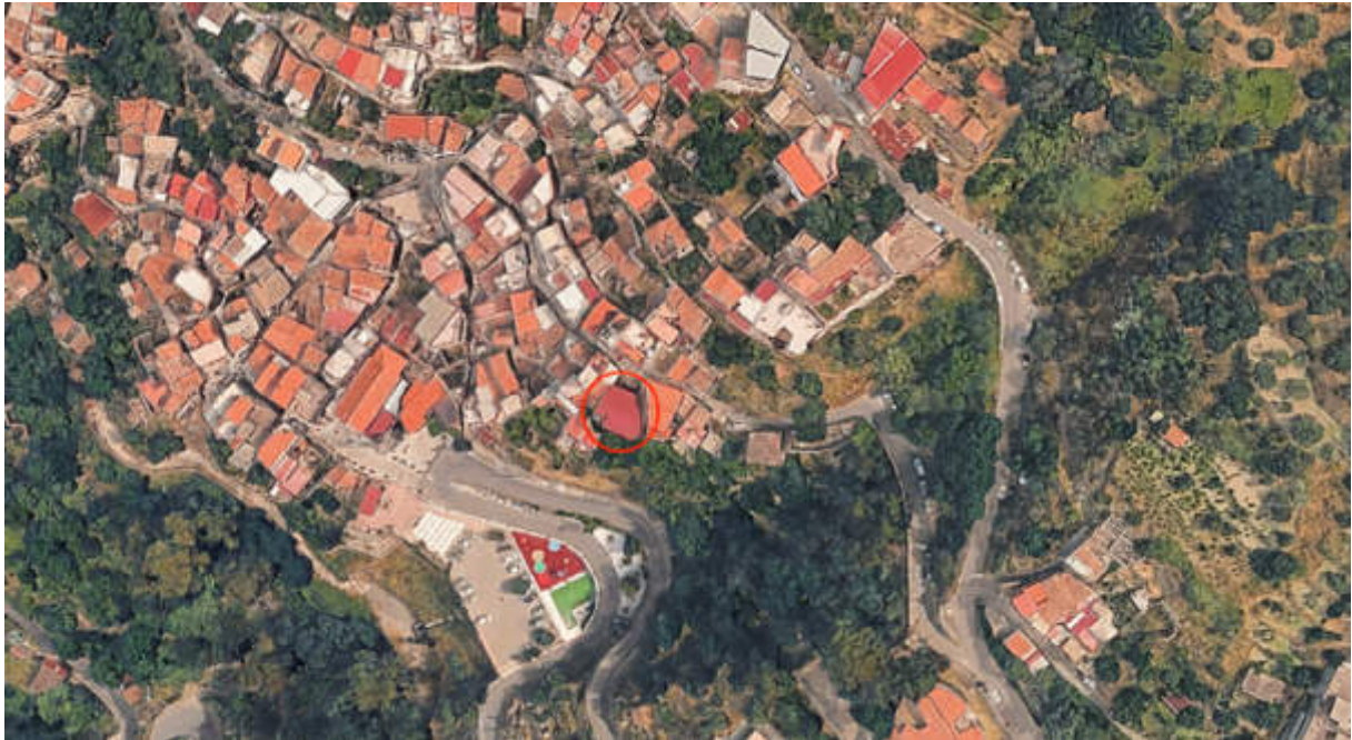
1. Fabbricato visto da Google Maps
