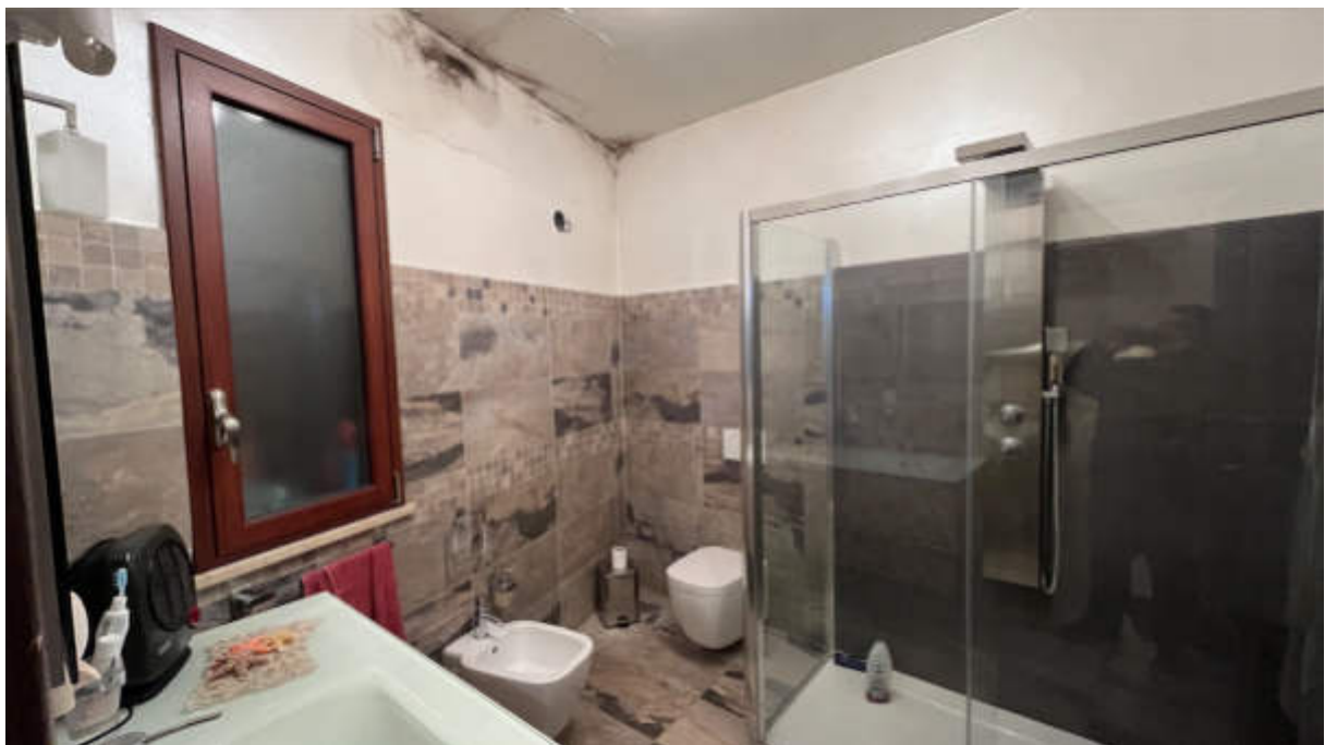
16. Vista 1 su Bagno al Piano Primo
