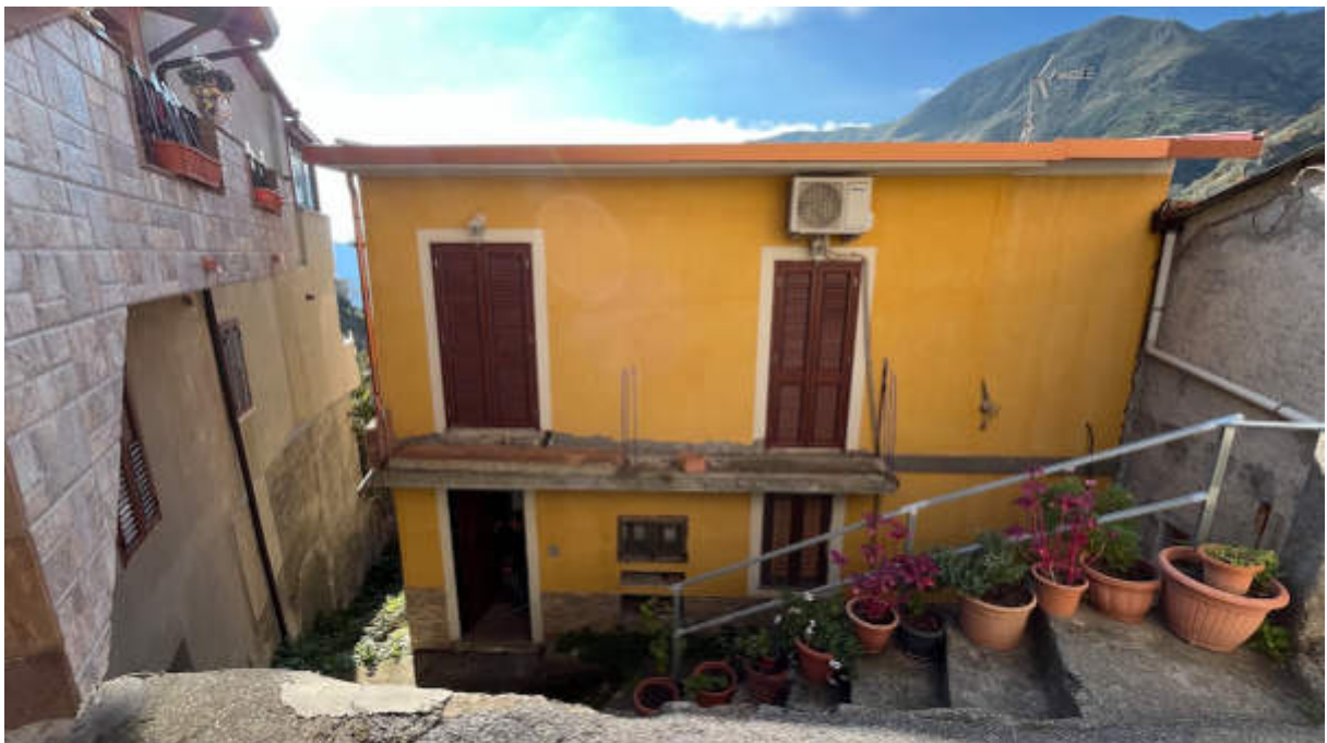
2. Vista su Fabbricato da Via Mazzini
