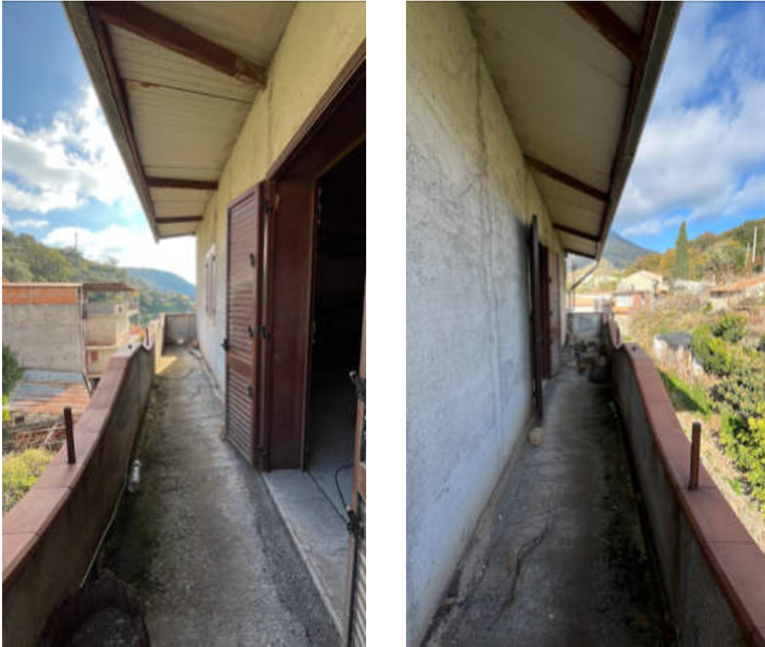
17. Vista 1 e 2 su Balcone al Piano Secondo
