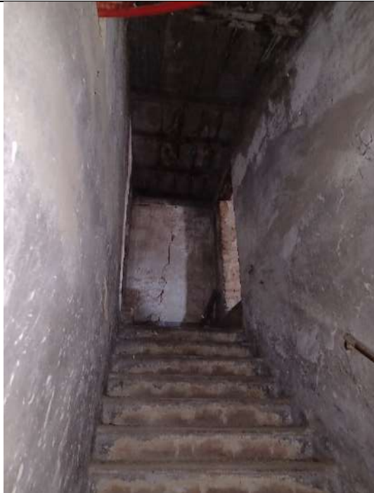
Immagine 17 - Scala interna tra piano primo e piano sottotetto
