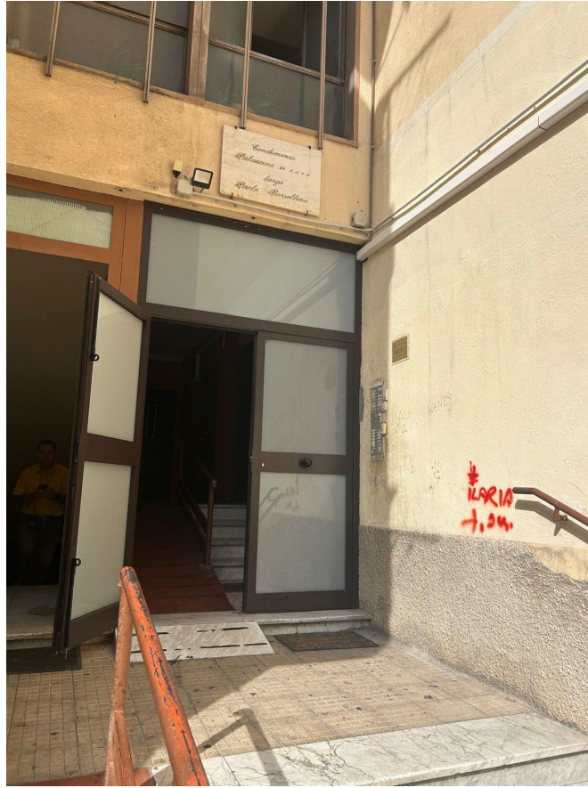
Figura 1 - Ingresso condominio Pal.24 IACP
