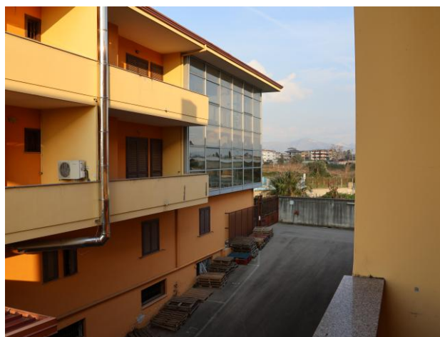
Rampa di accesso ai garage
