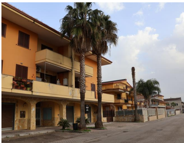
Prospetto fabbricato lungo via XI Settembre
