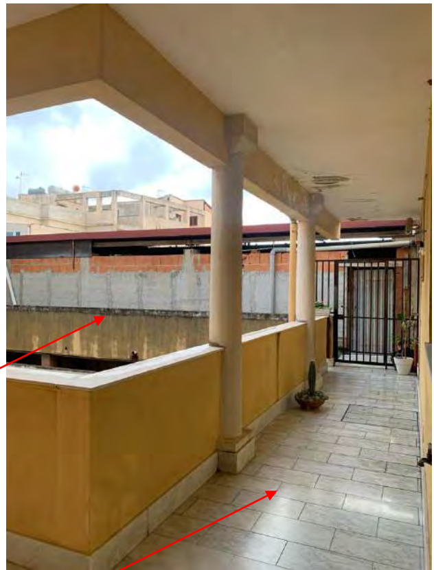
Ballatoio di ingresso condominiale
