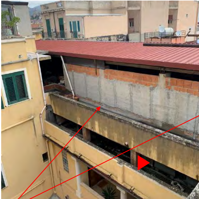
Ballatoio di accesso di proprietà del debitore
