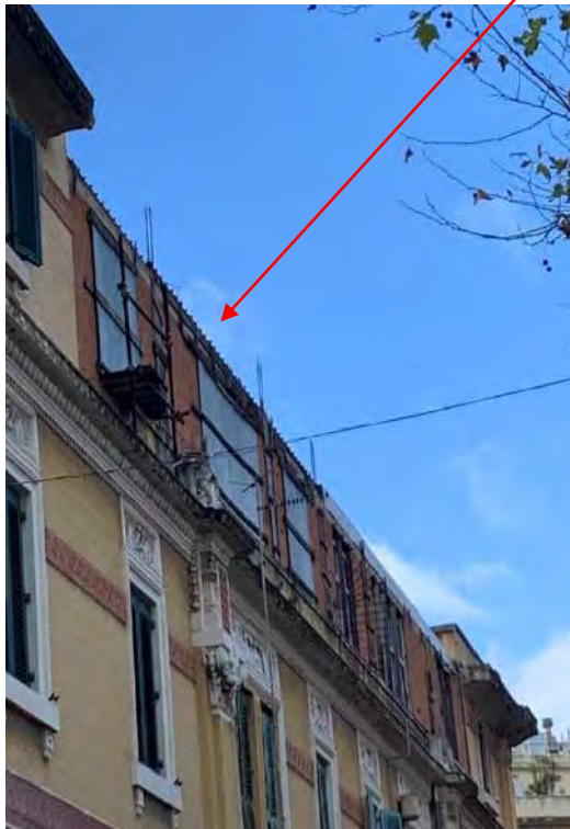
Particolare copertura in lamiera non praticabile e non accessibile - Prospetto su via Solferino
