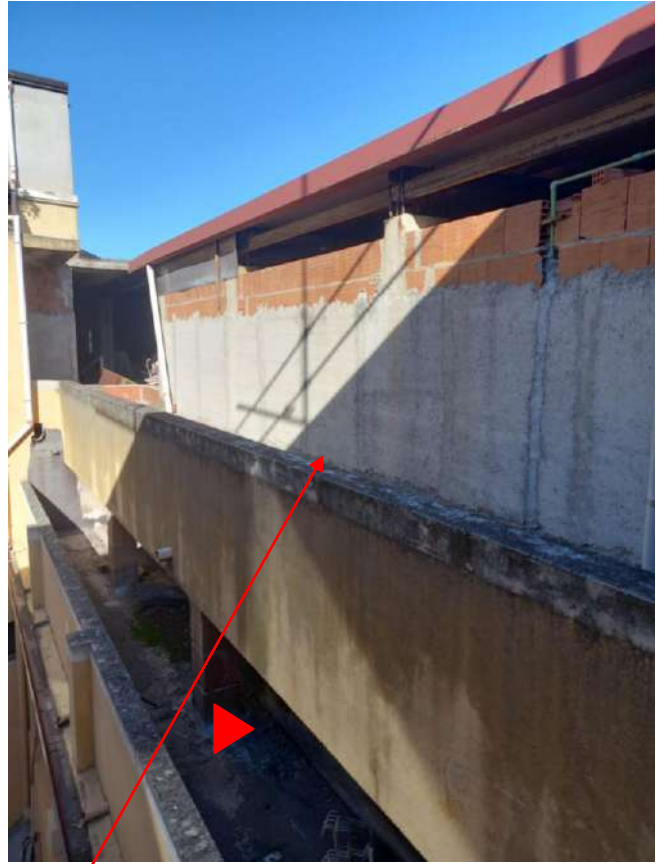
Ballatoio di accesso di proprietà del debitore
