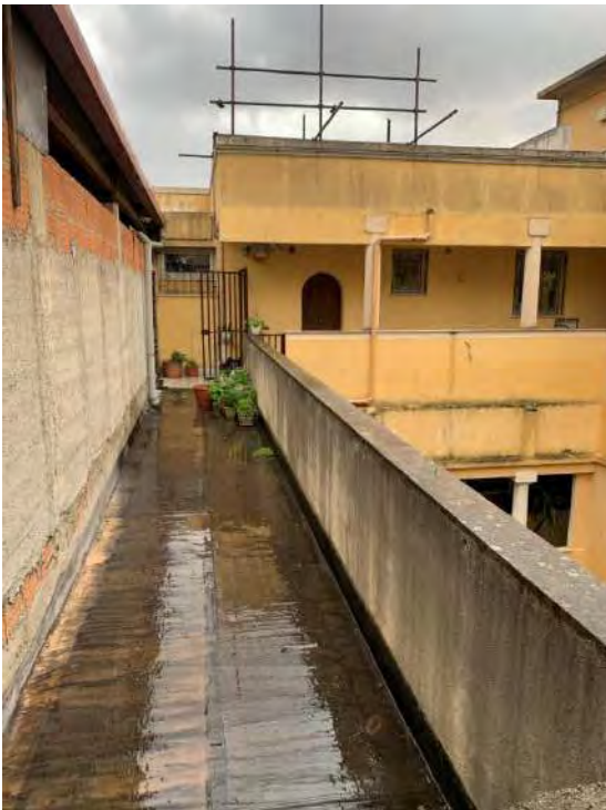
Vista ballatoio di proprietà del debitore
