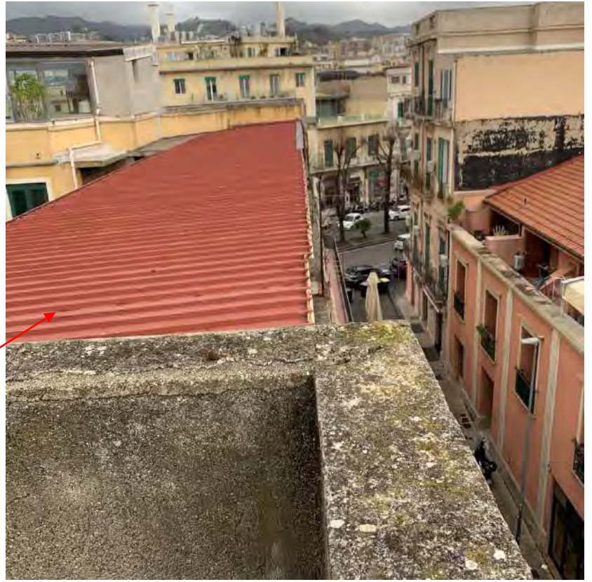
Particolare copertura in lamiera non praticabile e non accessibile - Prospetto su via Solferino
