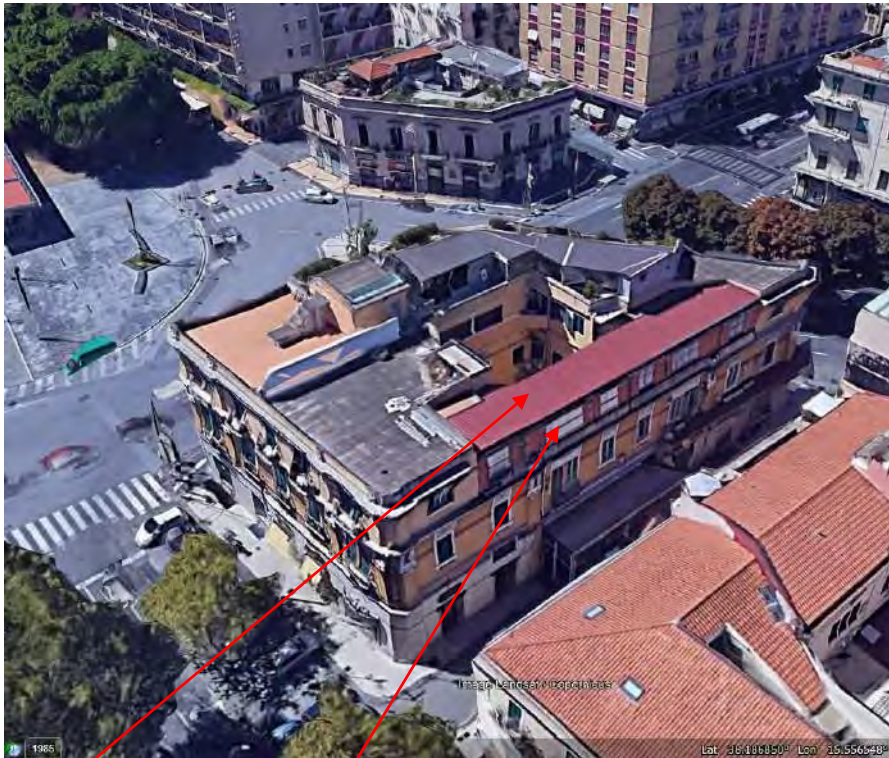
Copertura in lamiera sub 28 e 29 in corso di costruzione F/3 - piano 2°
