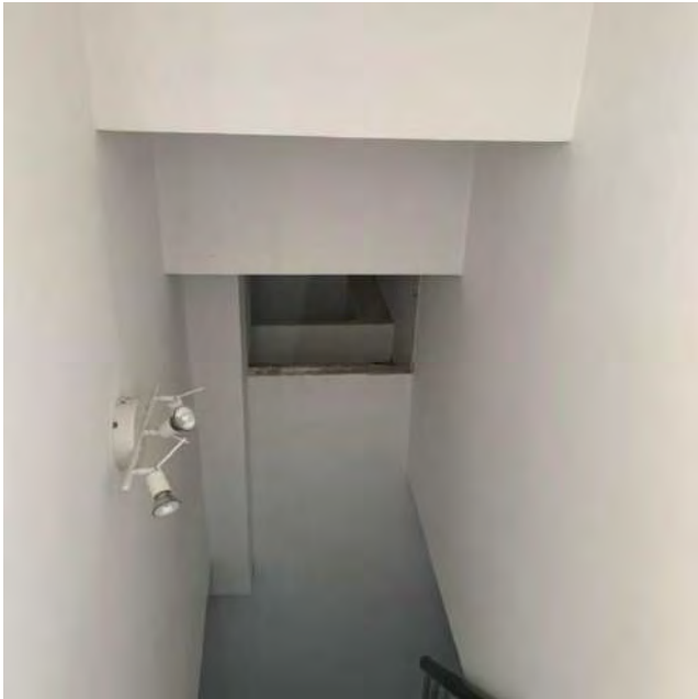
Preso aria dal bagno su scala interna
