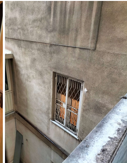
Foto 12 – Pozzo luce visibile dal corridoio
