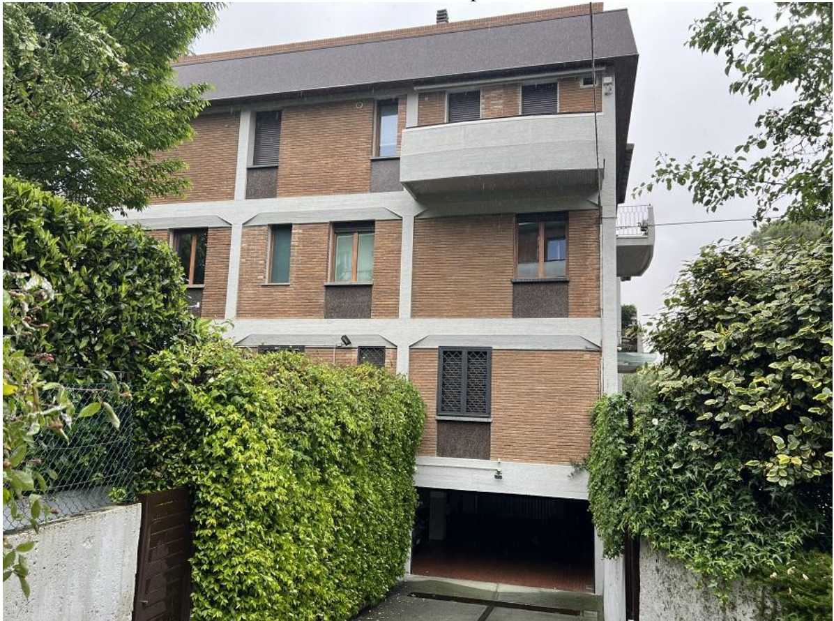
rampa condominiale interposta tra le due corti
