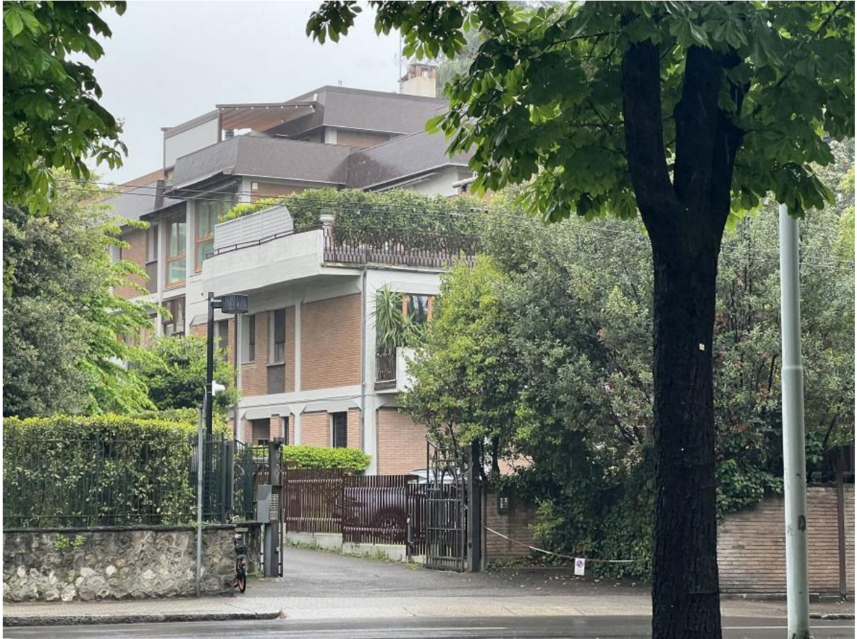
Vista condominio da viale Aldini
