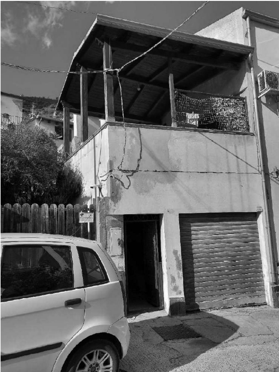
Foto 5) Ingresso dalla via scalette Umberto I n. 17
