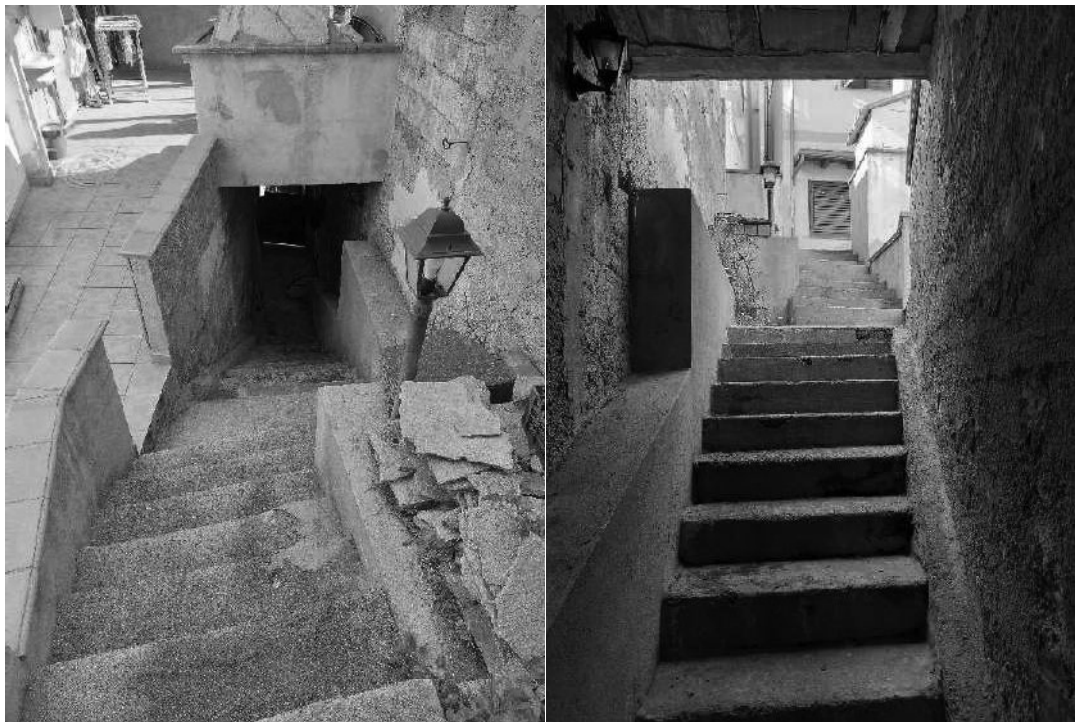
Foto 12, 13, 14, 15, 16 e 17) Vista dalla corte interna;
