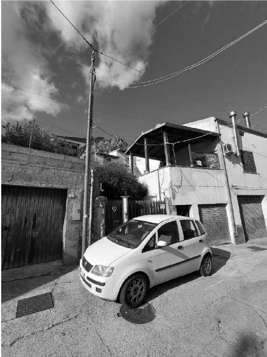
Foto 6) Ingresso dalla via scalette Umberto I n. 17
