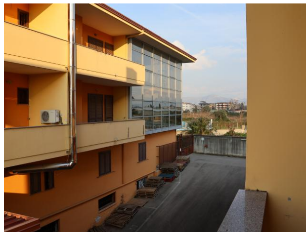
Rampa di accesso ai garage
