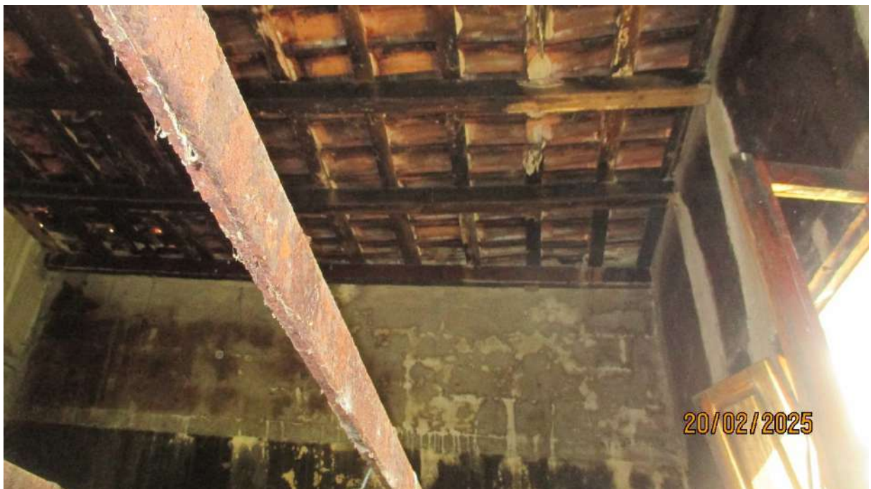
Figura 24. Idem come sopra - particolare soffitto
