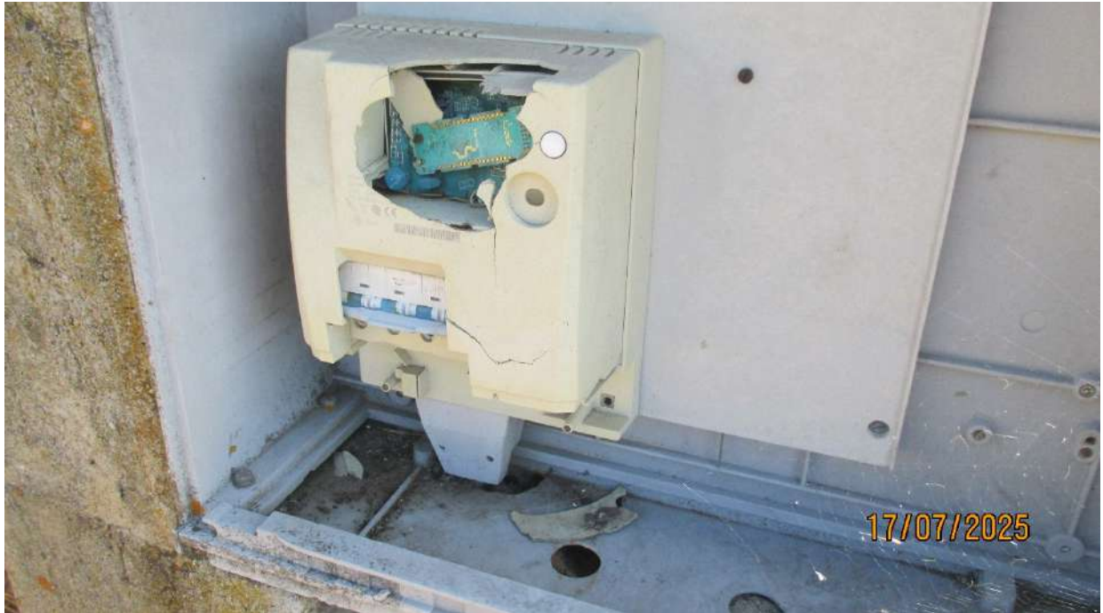
Figura 61. Contatore divelto
