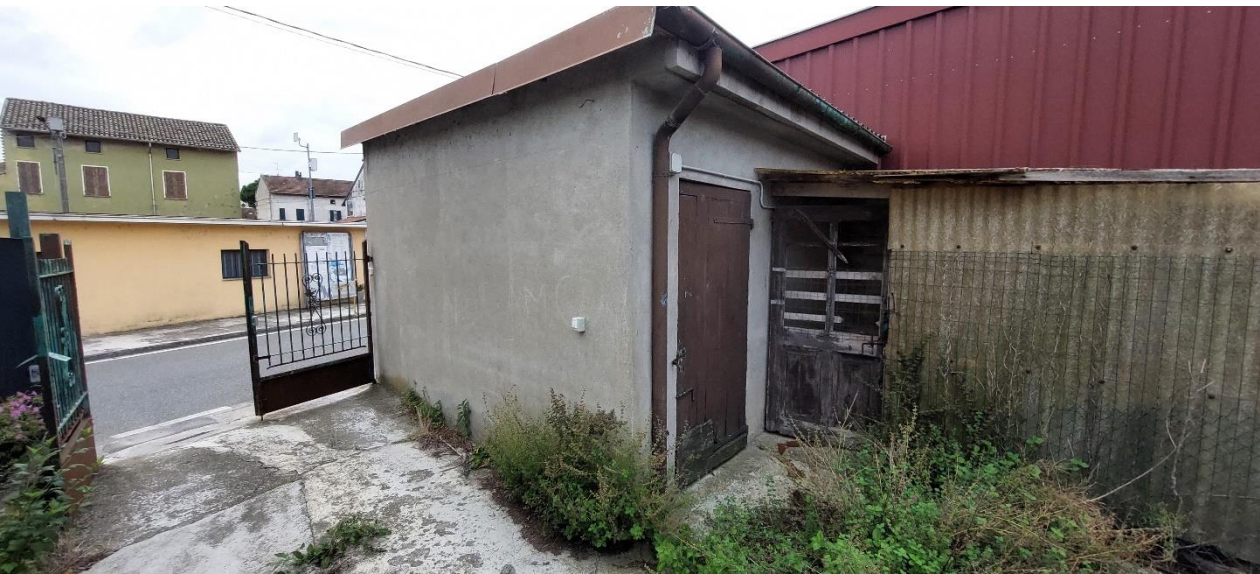
FOTO 2 – Garage retro su cortile interno
