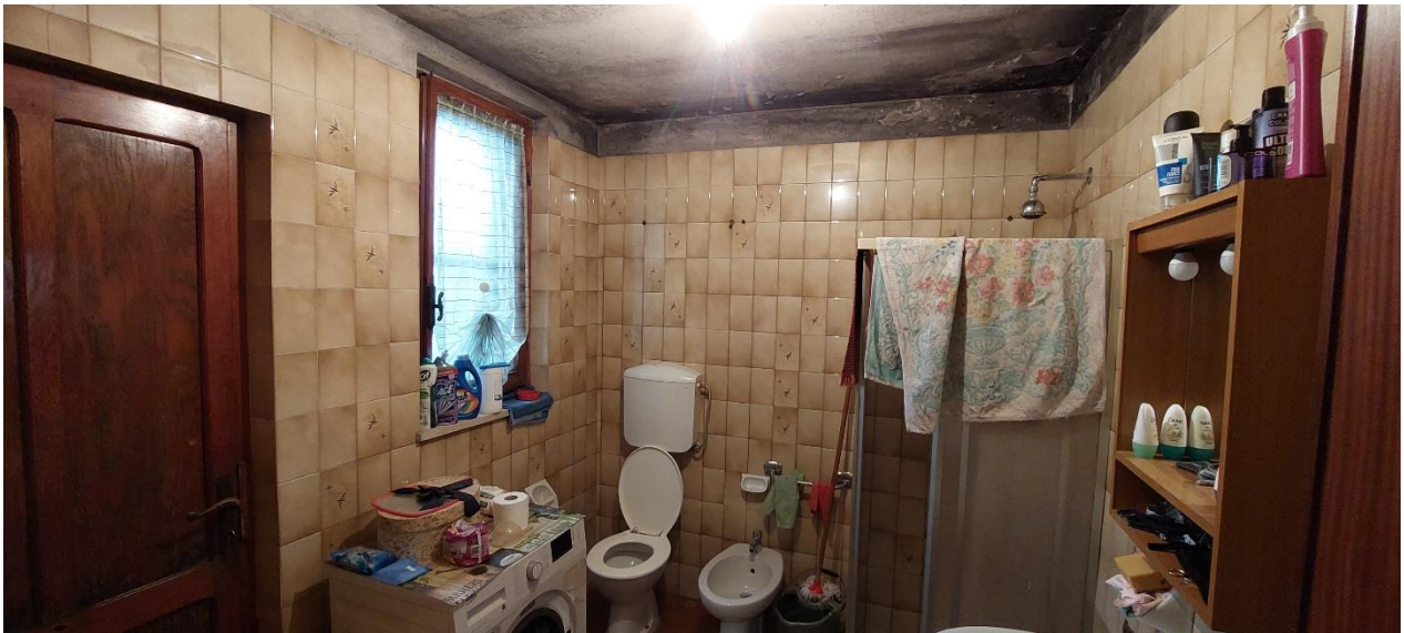
FOTO 13 – Bagno piano terreno
