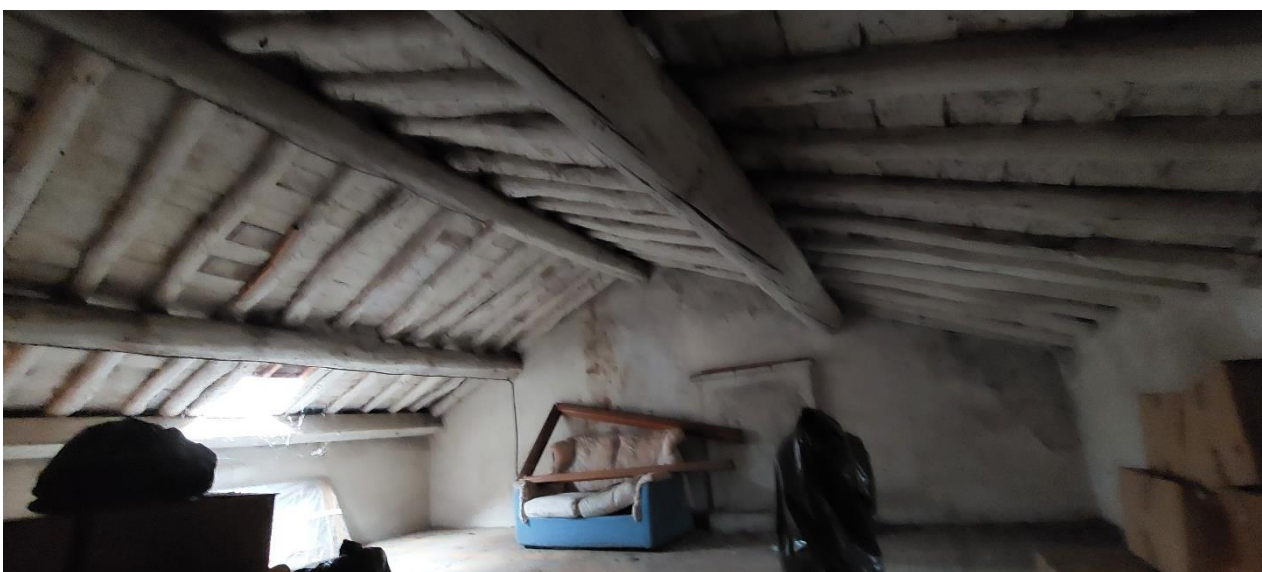
FOTO 28 – Sottotetto non abitabile
