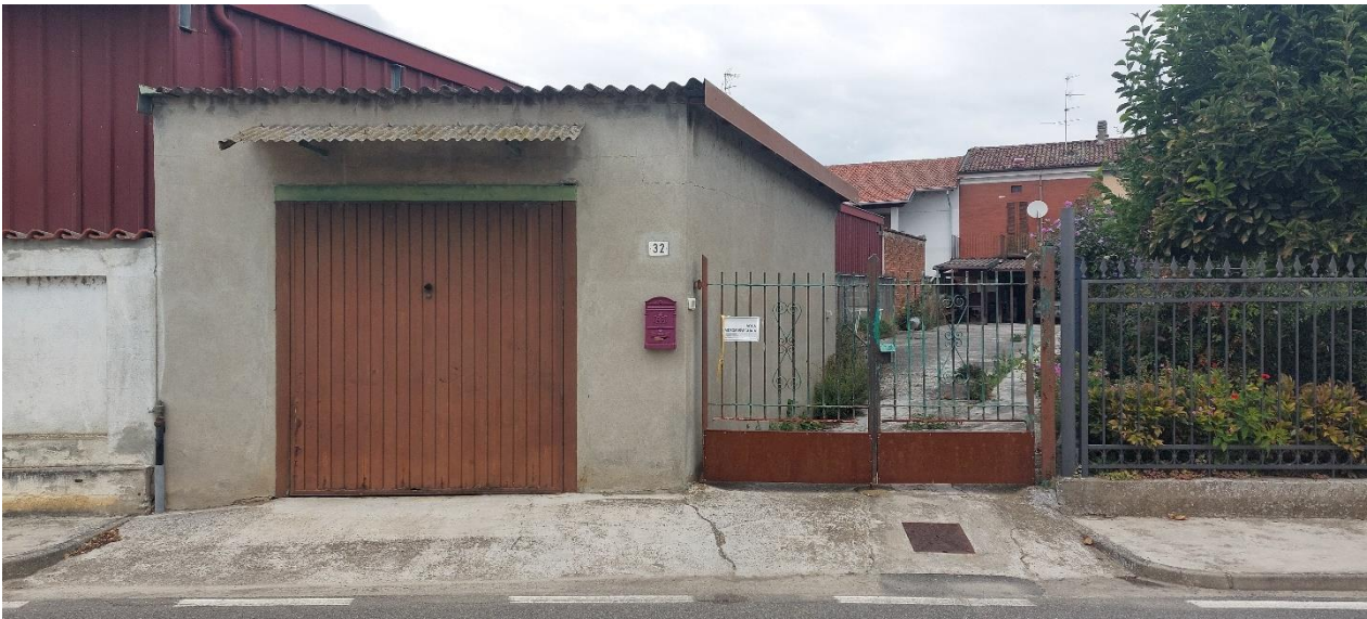
FOTO 1 – Facciata su Via Roma n.32
