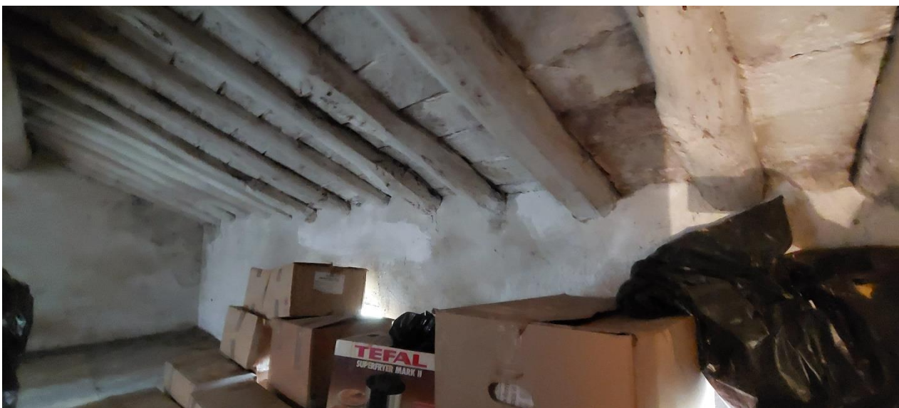
FOTO 27 – Sottotetto non abitabile
