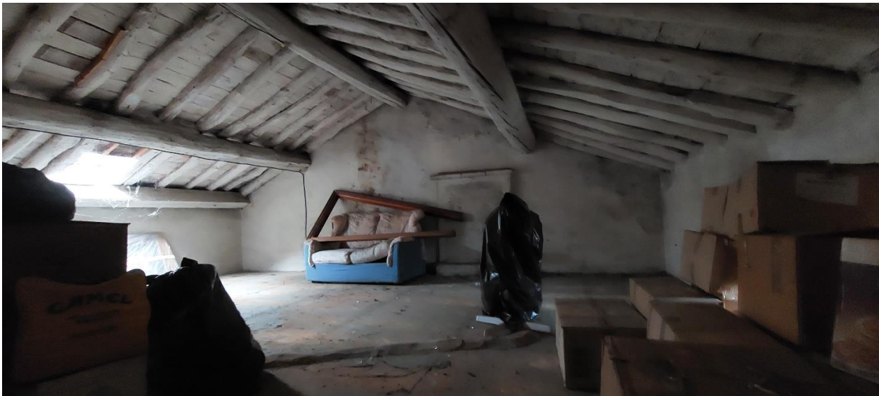
FOTO 26 – Sottotetto non abitabile
