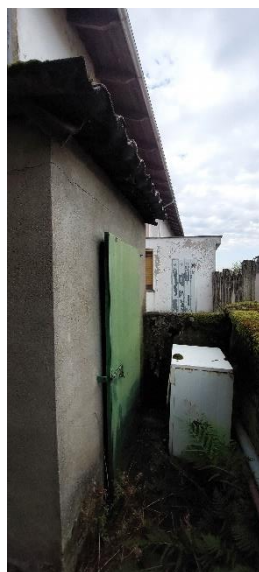
FOTO 18 – Ingresso locale ripostiglio-centrae termica
