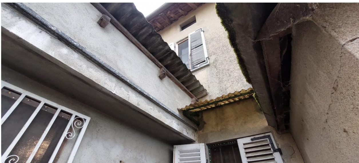
FOTO 17 – Facciata nord fabbricato
