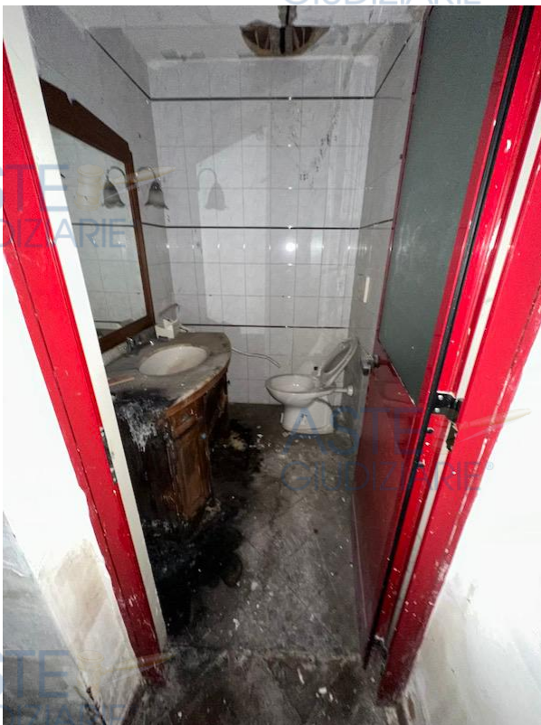
Foto n.7 – Bagno in locale deposito
