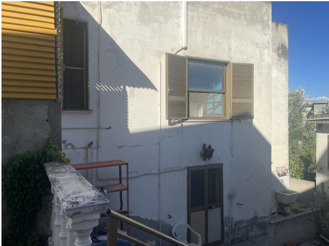
Vista della porta di ingresso al locale al piano seminterrato
