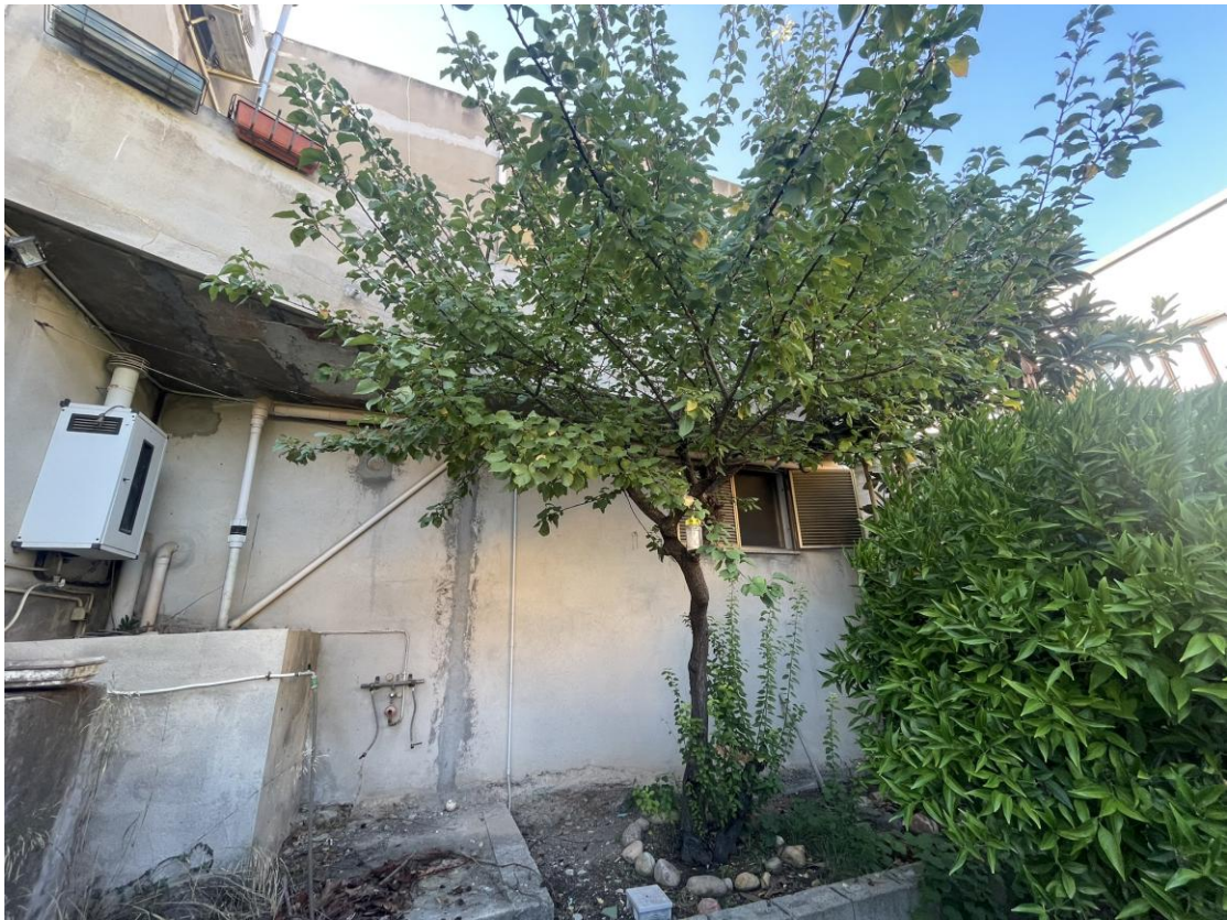
Vista del prospetto posteriore
