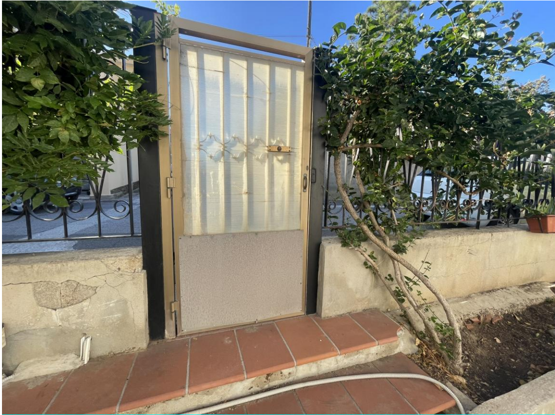
Vista del cancello di accesso pedonale
