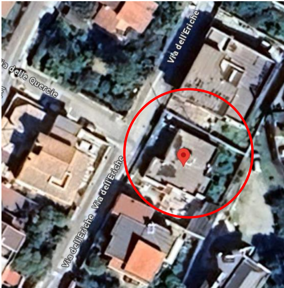
Foto aerea dell'area con evidenziato il fabbricato
