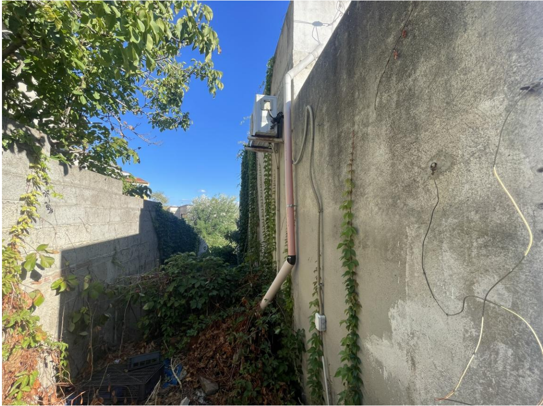
Vista del prospetto laterale destro
