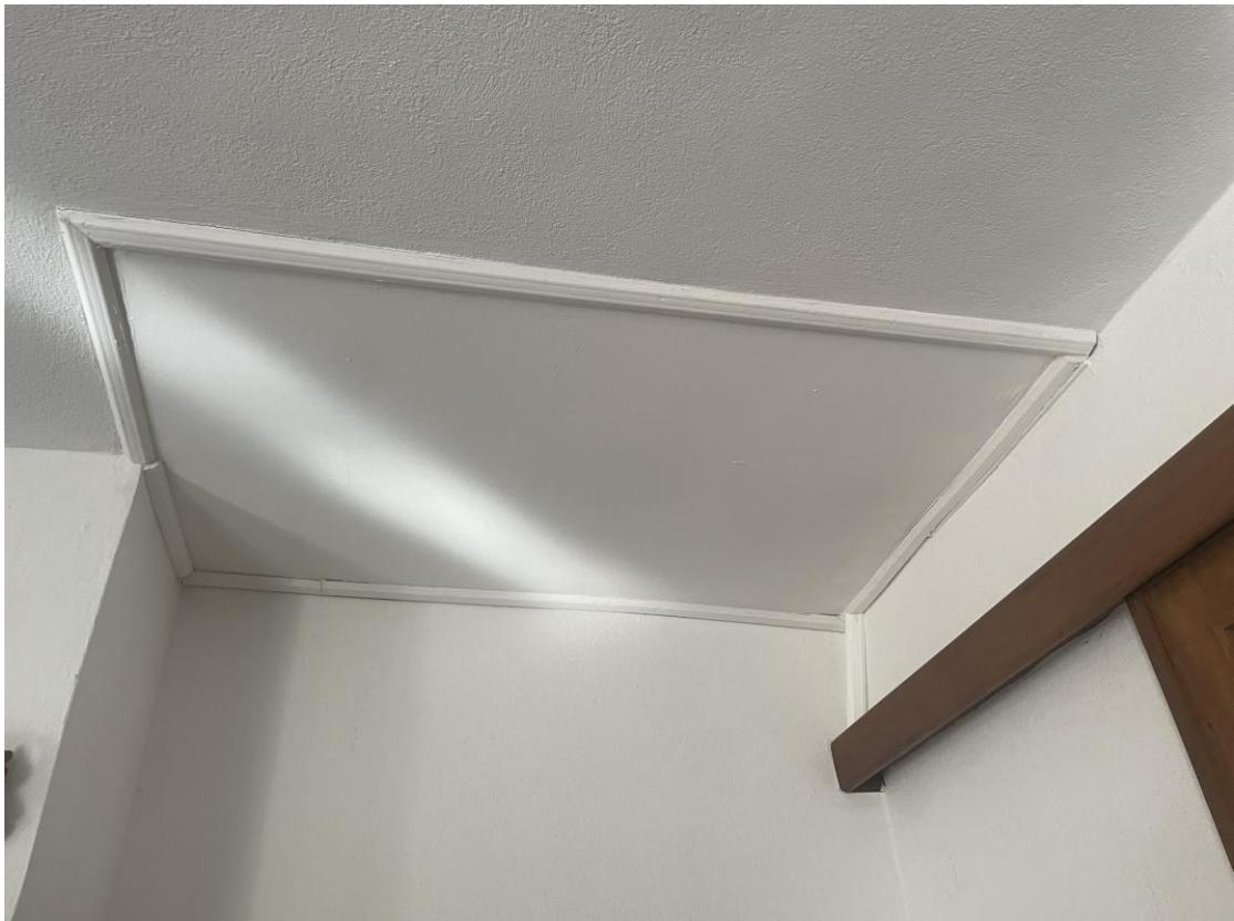
Predisposizione per il collegamento con la copertura
