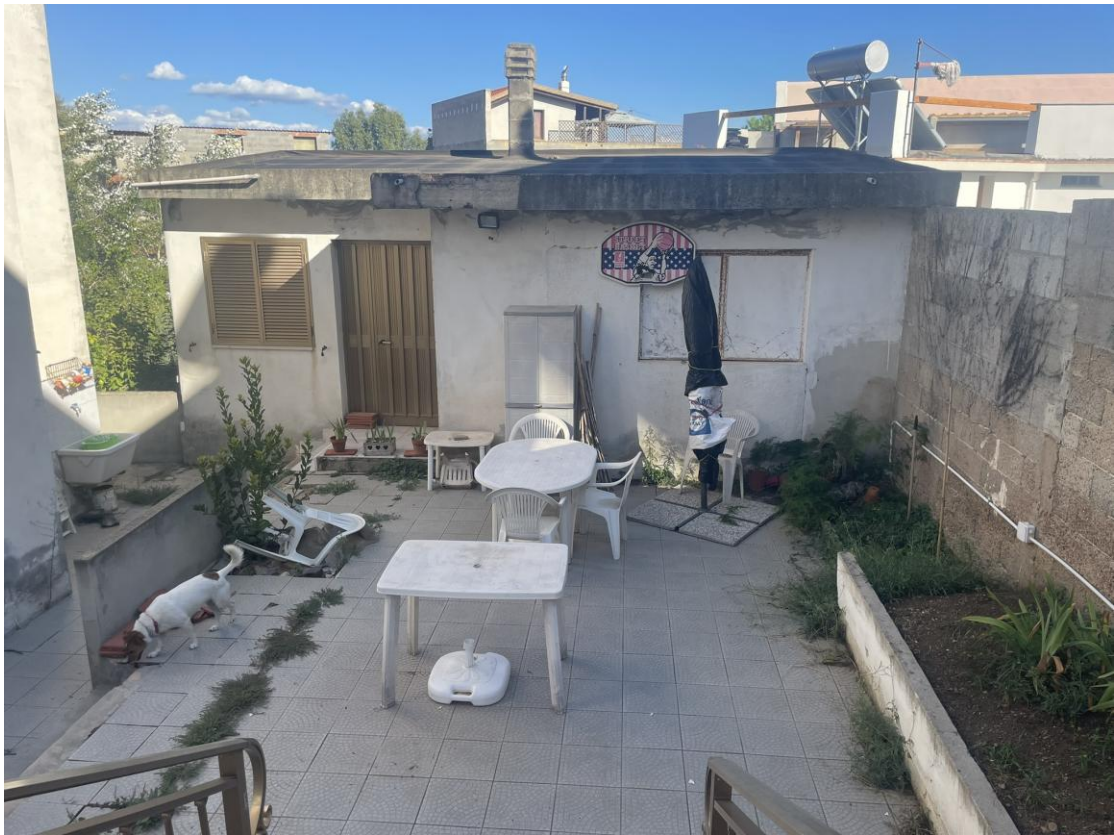
Vista del vano accessorio esterno
