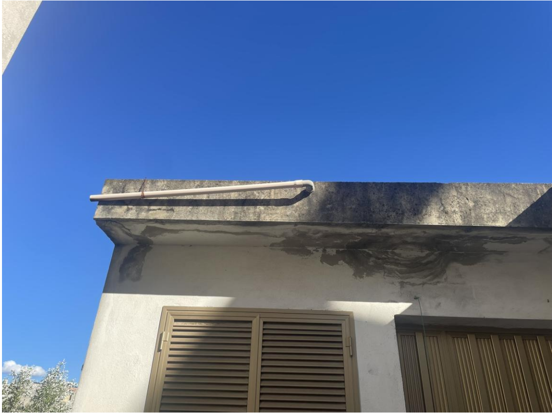
Copertura del locale accessorio
