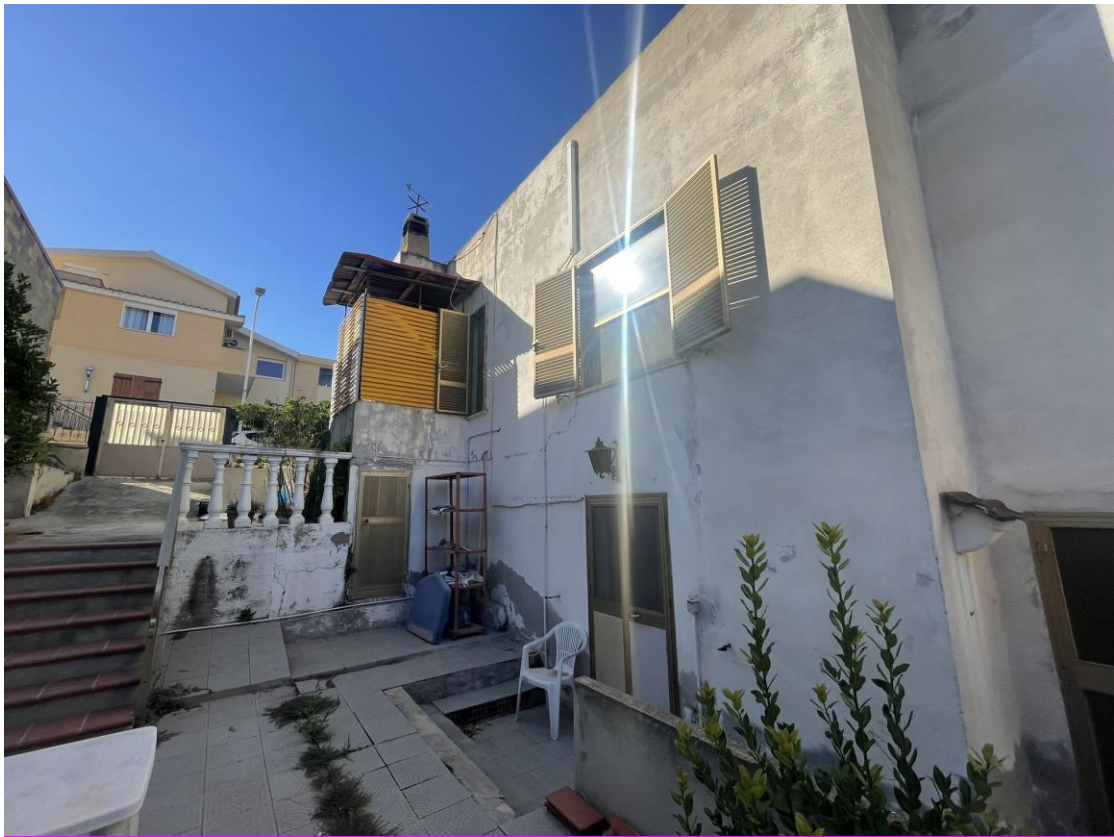
Vista del prospetto laterale destro
