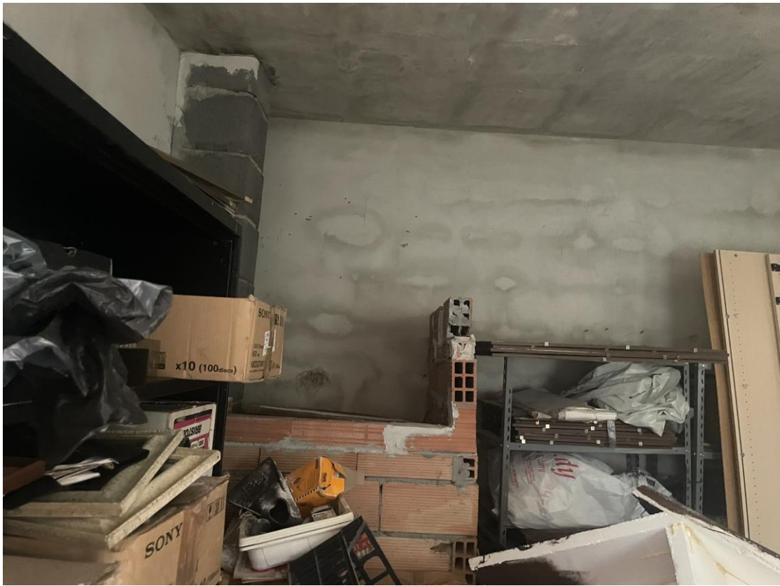
Vista interna del locale garage
