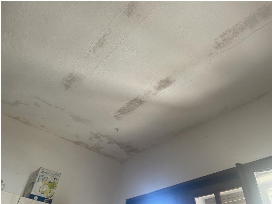
Particolare del soffitto della cucina
