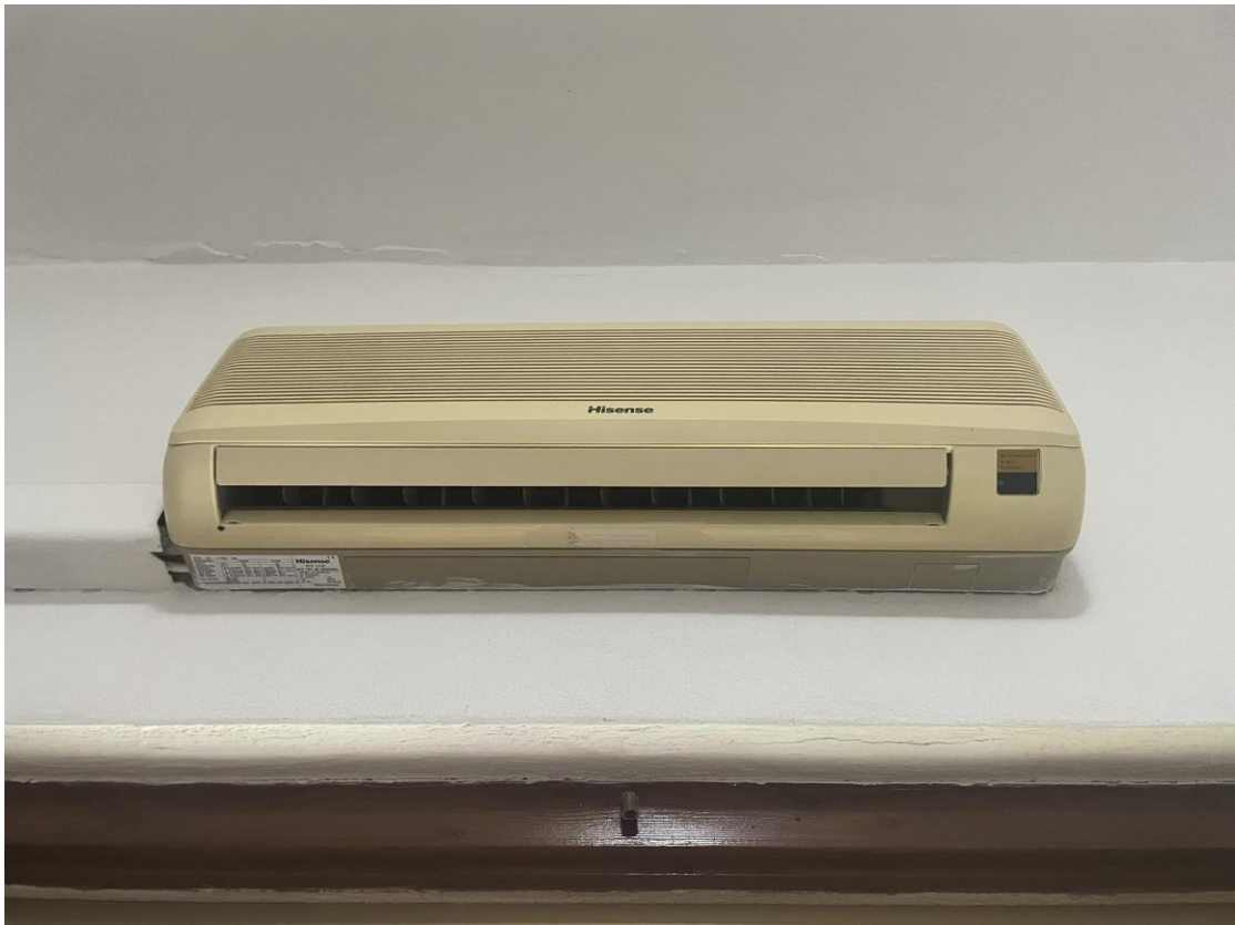
Dettaglio della pompa di calore delle camere
