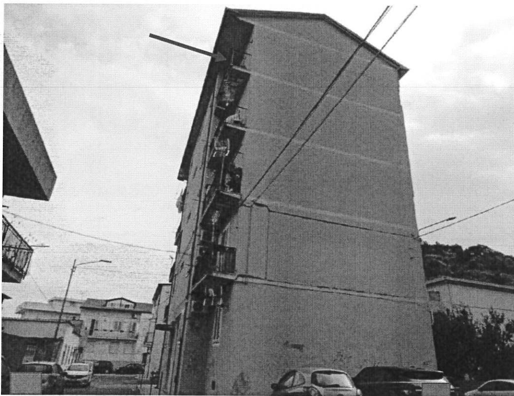
Foto 1 – Vista stabile da Via Bainsizza
