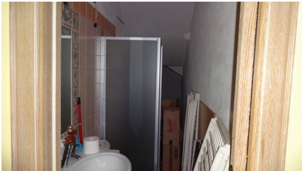
Foto 5 – Punto di scatto 05 – W.C. a piano terra
