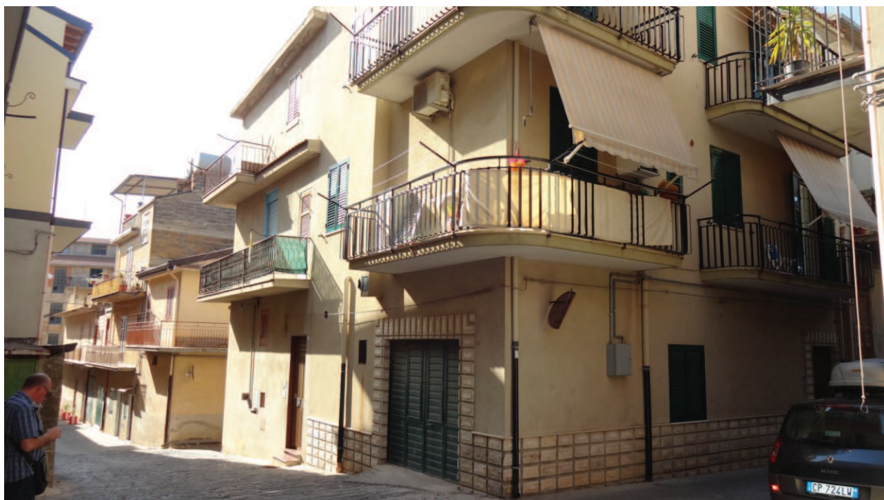
Foto 1 – Punto di scatto 01 – Prospetto Via Pepe – via Settembrini
