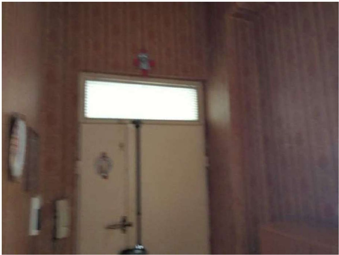
Foto n. 4 – Vista del portoncino d'ingresso dell'abitazione
