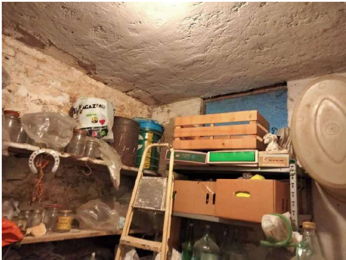
Foto n. 20 – Vista interna della cantina
