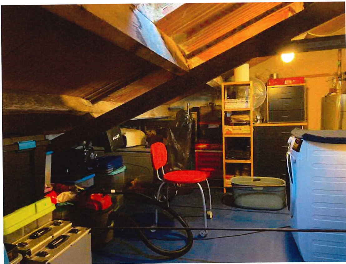
Foto 21 - Soffitta al piano quarto
