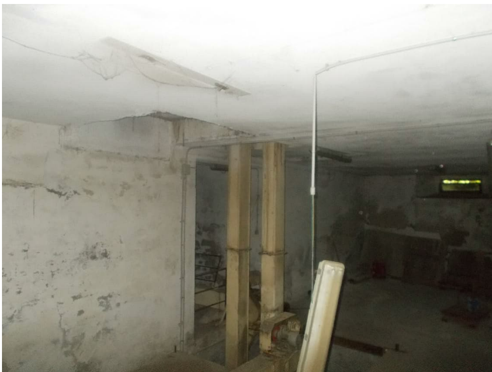
Foto n. 22 –Interno Immobile Garaguso Piano S1
