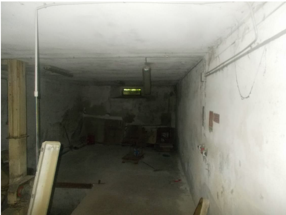
Foto n. 20 –Interno Immobile Garaguso Piano S1
