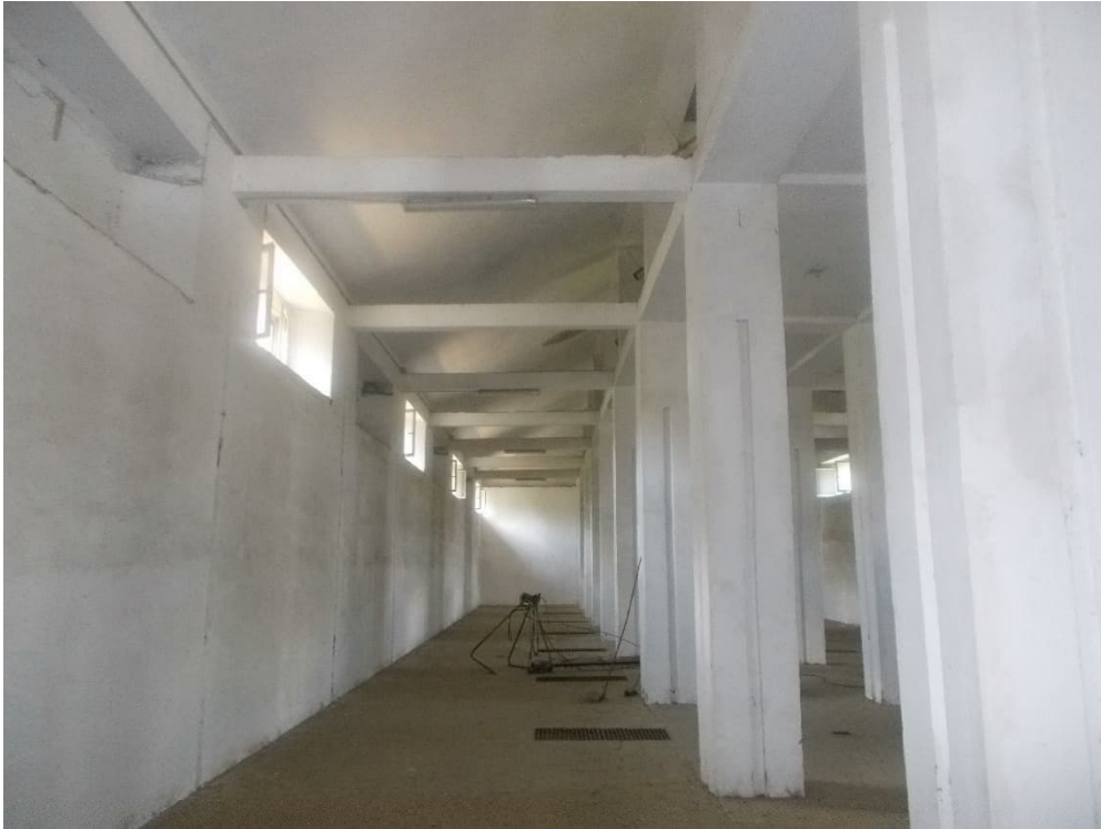
Foto n. 19 –Interno Immobile Garaguso Piano T
