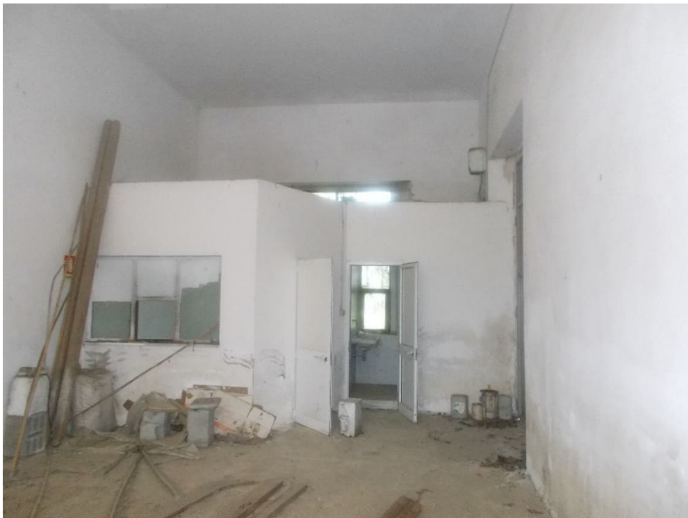
Foto n. 16 –Interno Immobile Garaguso Piano T
