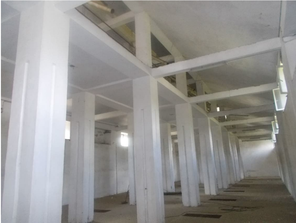
Foto n. 18 –Interno Immobile Garaguso Piano T
