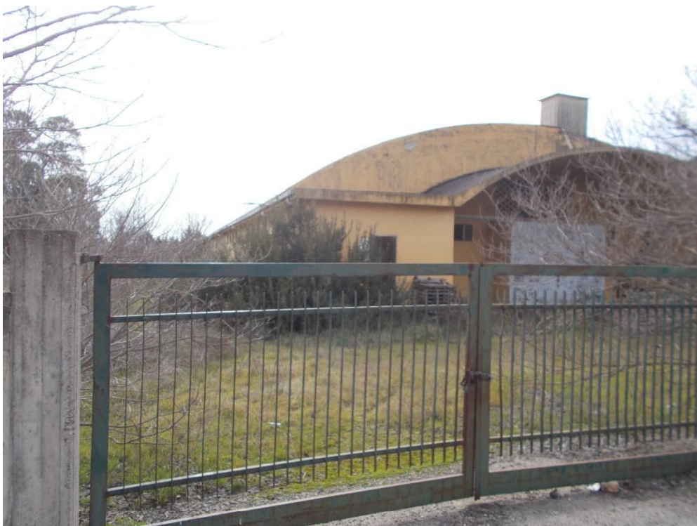
Foto n. 2 – Esterno Immobile Ferrandina
