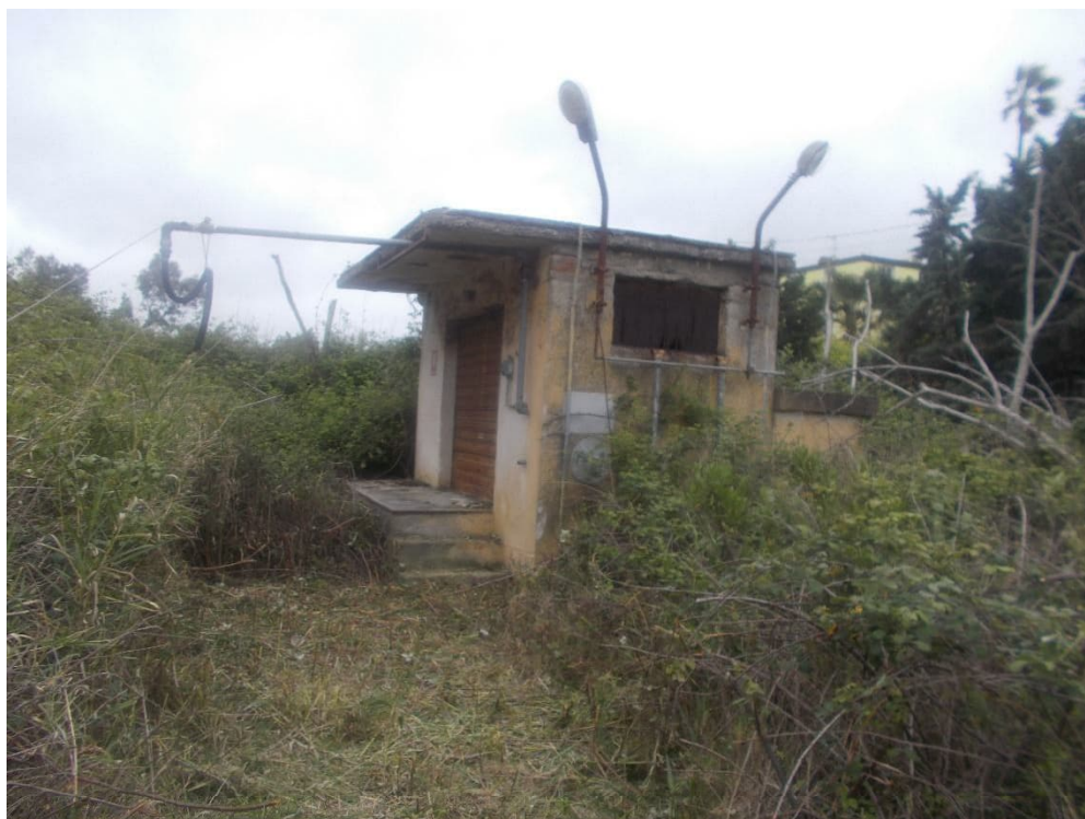
Foto n. 9 –Deposito carburanti Ferrandina
