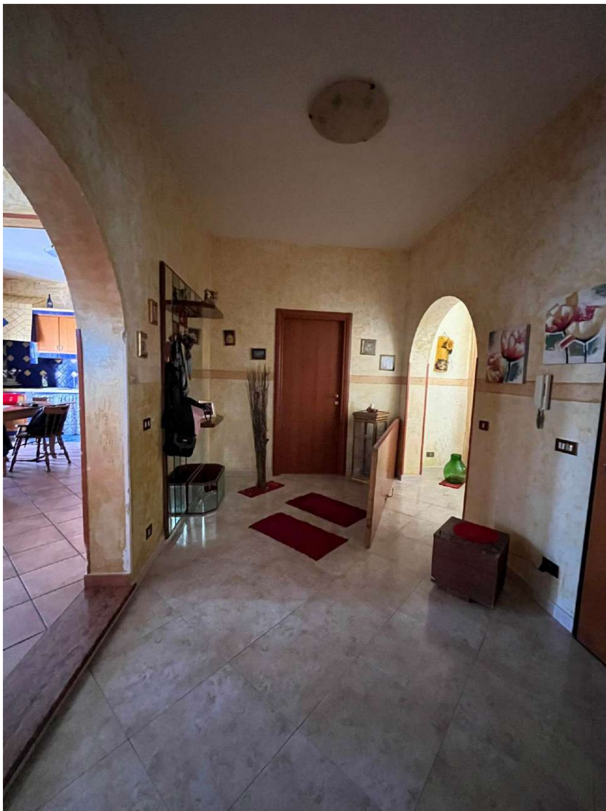
Foto 1 – Vista sull'ingresso dell'appartamento. Sulla destra si vede l'apertura nella muratura che ha unito i due precedenti appartamenti
