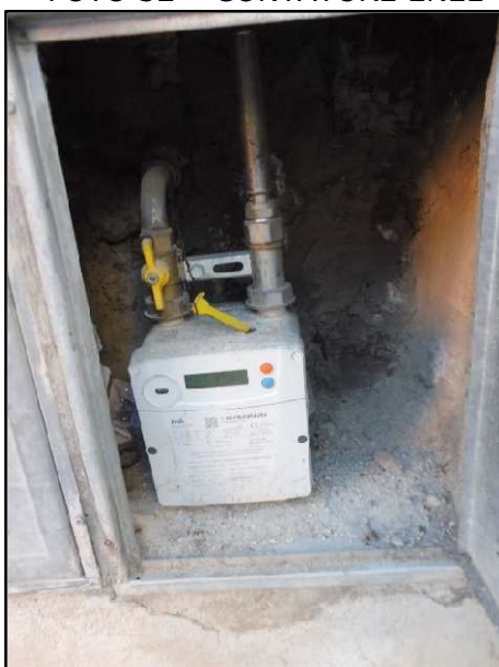
FOTO 33 - CONTATORE GAS
