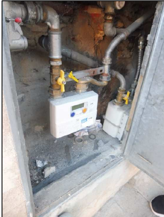
FOTO 34 - CONTATORE GAS
